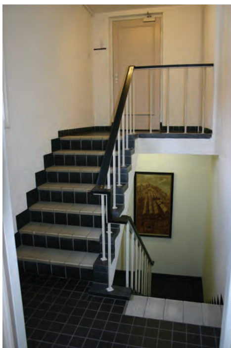
Afbeelding: Het interieur met het trappenhuis van het gebouw G.
