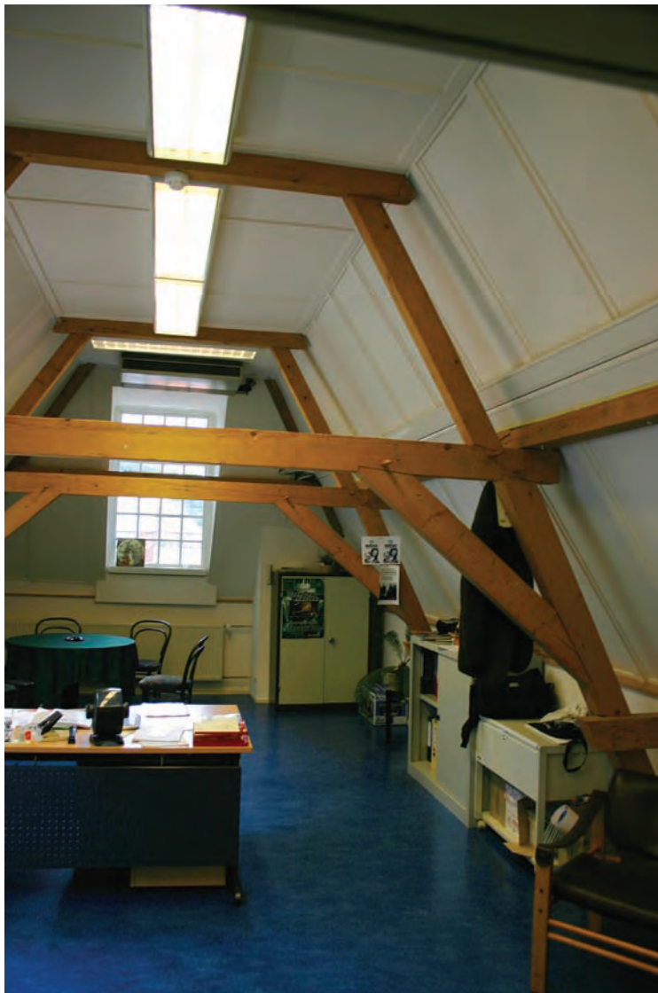
Afbeelding: De kap van het bouwdeel I gezien richting het noorden.
