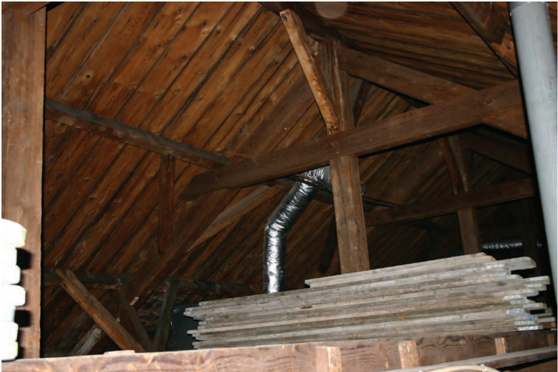
Afbeelding: De kapconstructie van het gebouw B.
