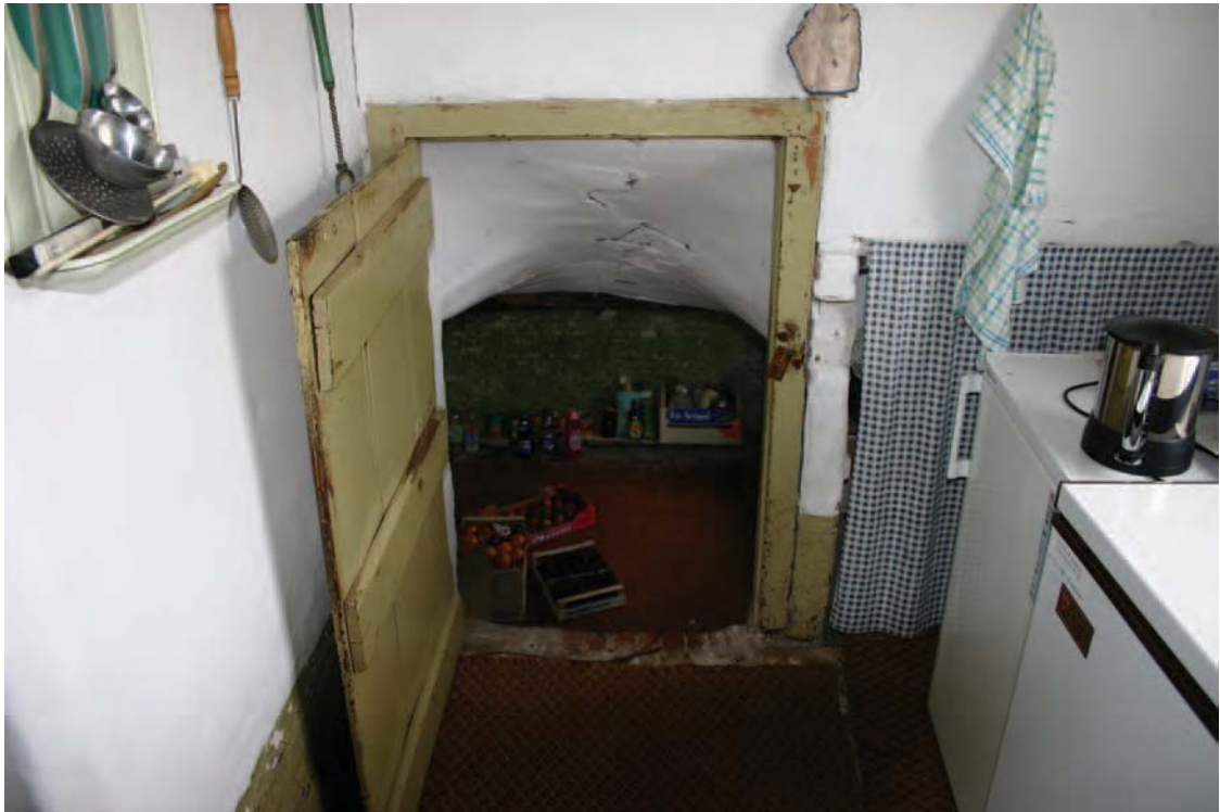
Afbeelding 15: De keldertoegang in de keuken (ruimte 3).
