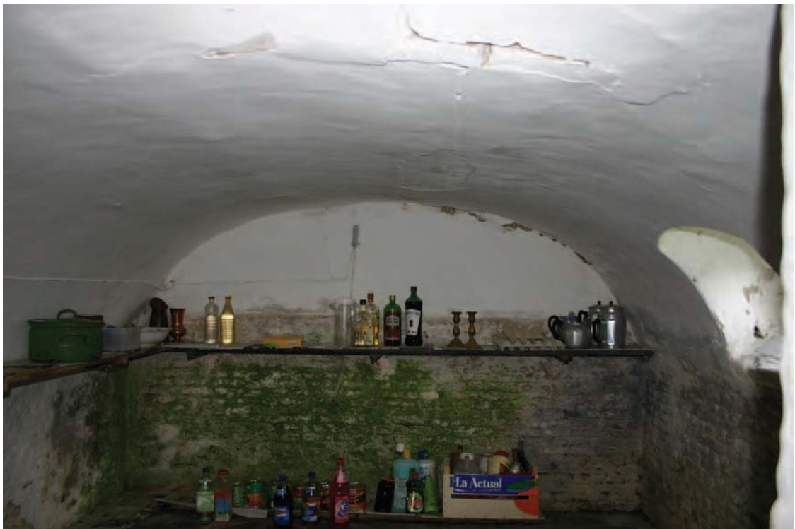
Afbeelding 16: De kelder onder de opkamer (ruimte 5).
