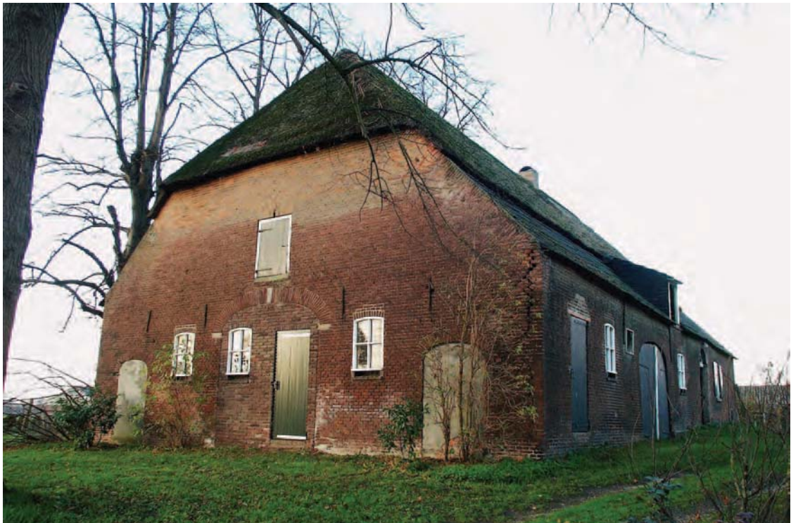
Afbeelding 03: De zuidelijke gevel.
