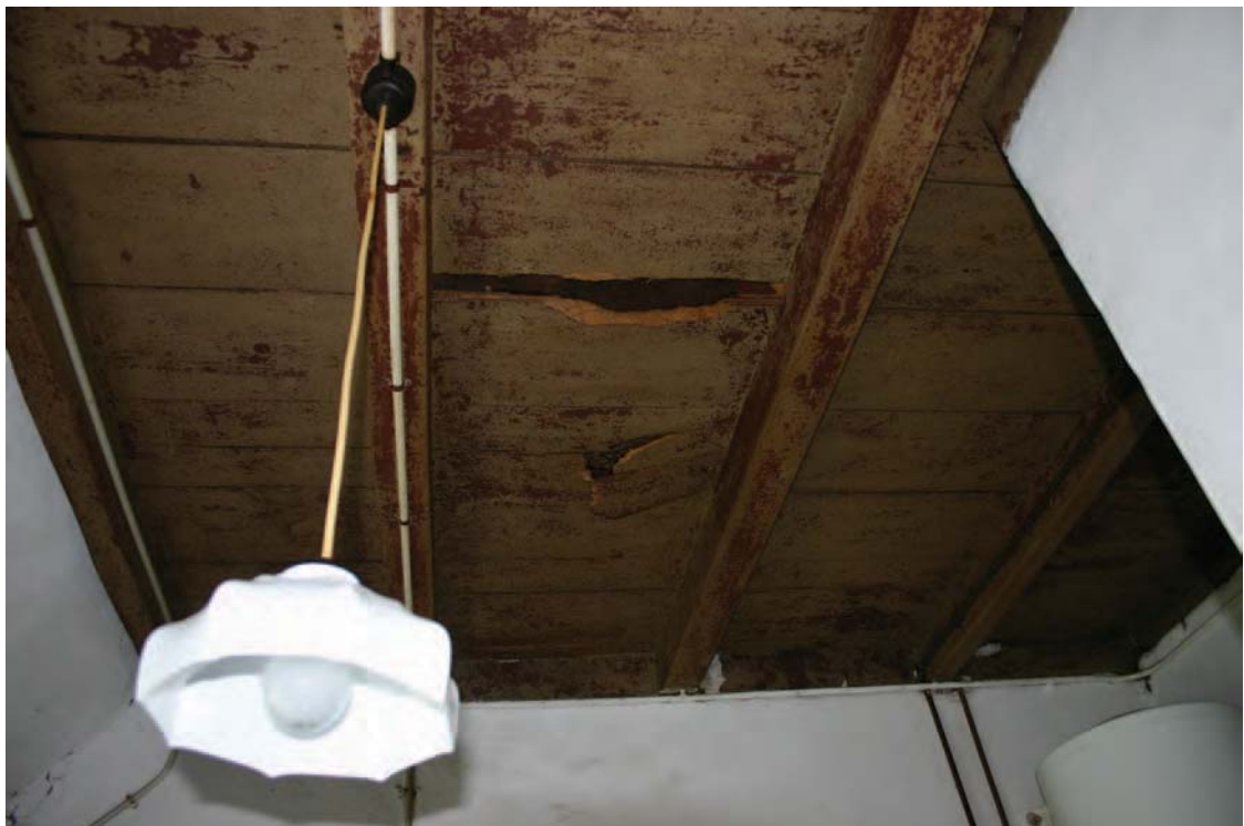
Afbeelding 14: Zicht op de balklaag en de vloerdelen in de opkamer (ruimte 2).
