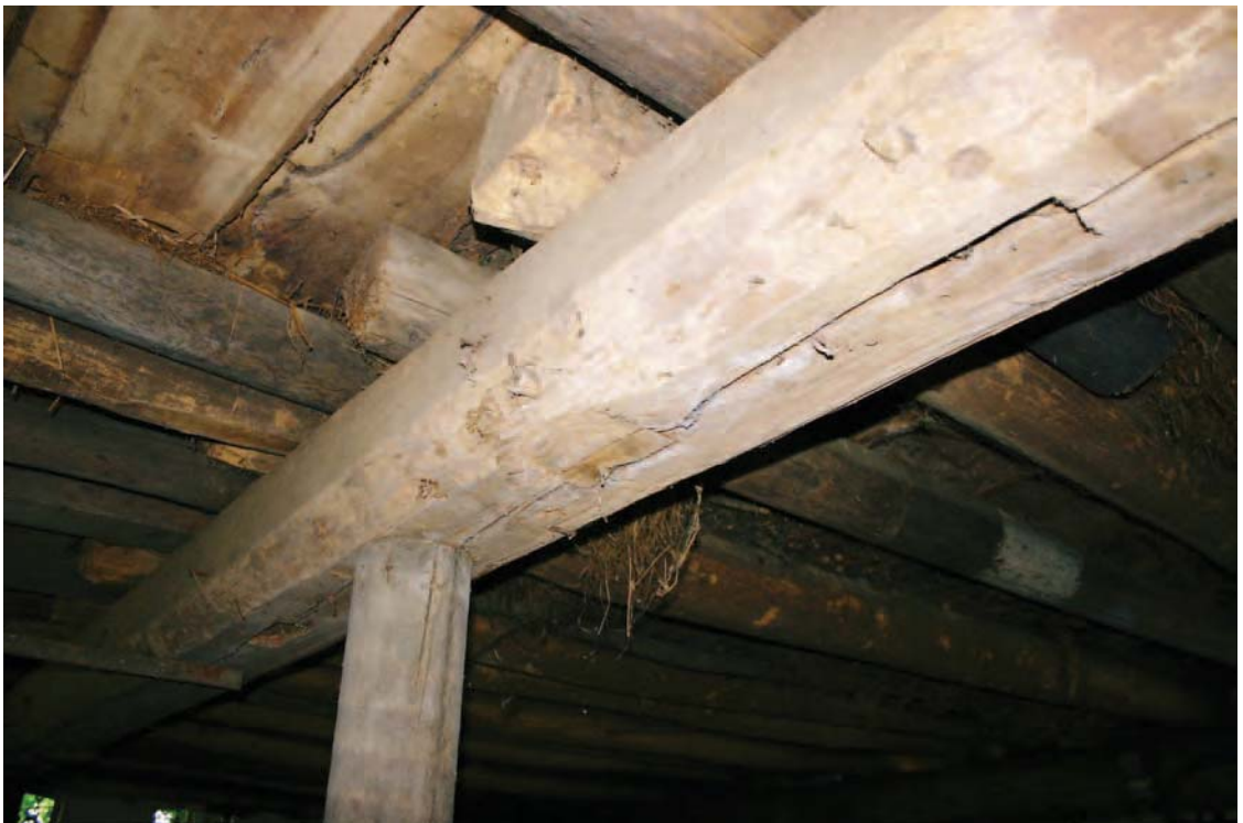
Afbeelding 22: Detail van één van de balken in de stal.
