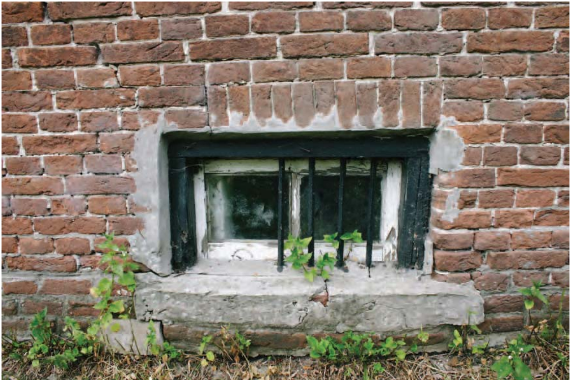
Afbeelding 6: Detail van het vergrote kelderlicht in de oostelijke gevel.
