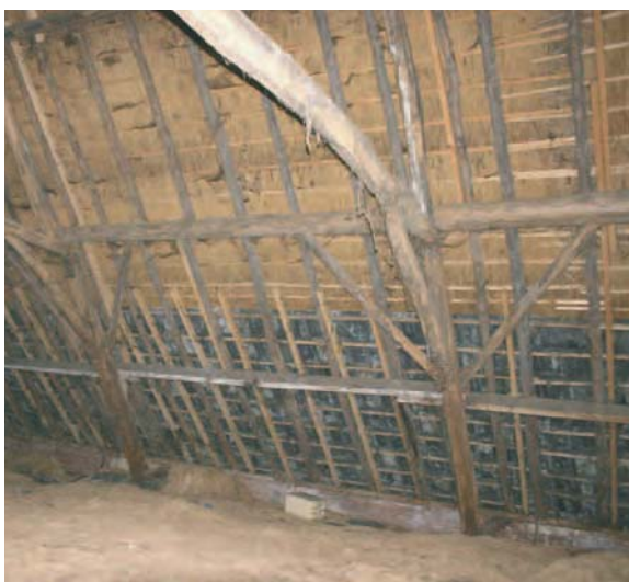
Afbeelding 24: Illustratie van een deel van de kapconstructie boven het staldeel.
