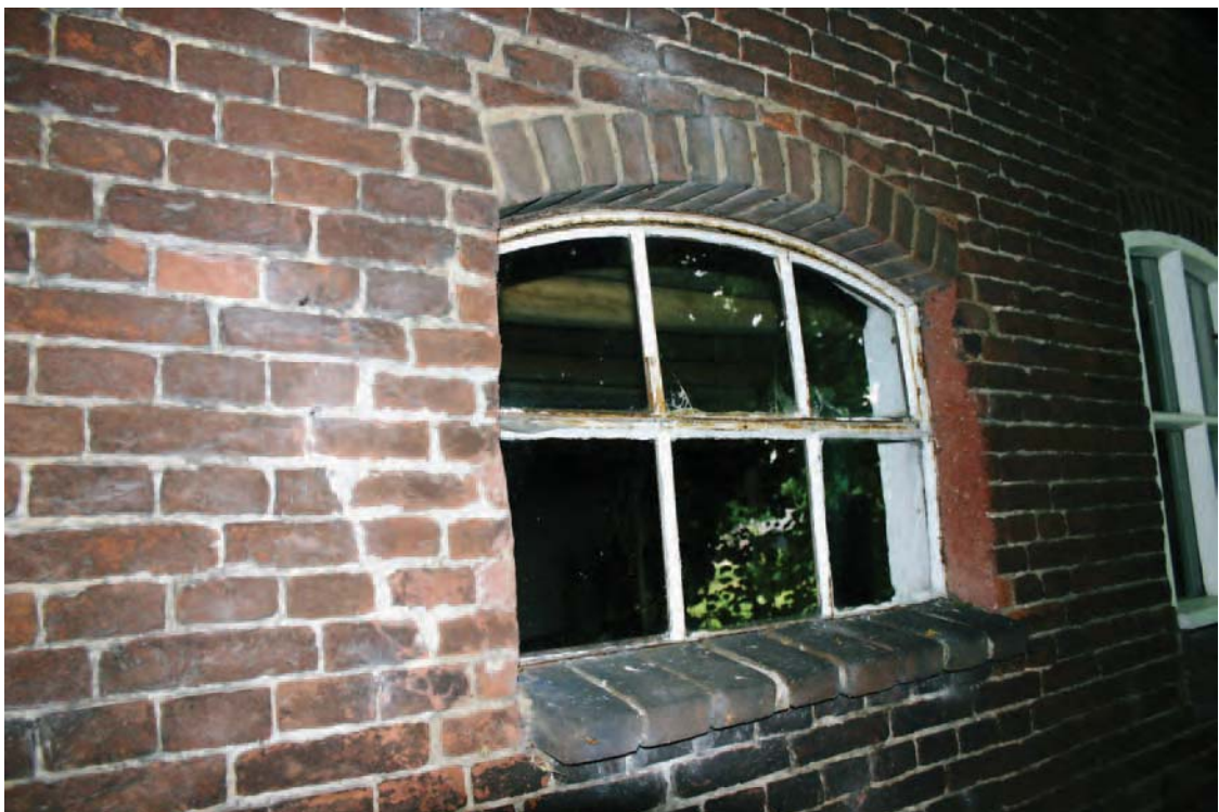
Afbeelding 11: Detail van een stalvenster in de westgevel.
