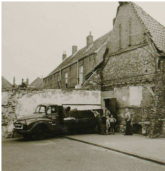
Afbeelding 11. Een foto uit omstreeks 1955 met een gezicht op het pand vanuit de Louwsche poort. Rechts vooraan een doorsnede van het verder gesloopte Paters Quartier. Duidelijk zichtbaar is het tussenbalk juk.
