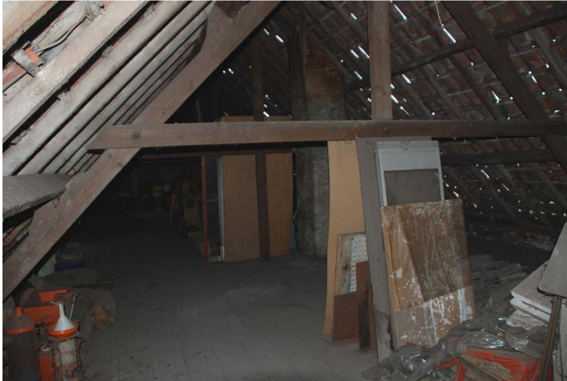
Afbeelding 6. De zolder gezien naar het zuiden met de onbeschoten kap met groene A-spanten met dubbele trekplaten en een op de zoldervloer dragende makelaar.
