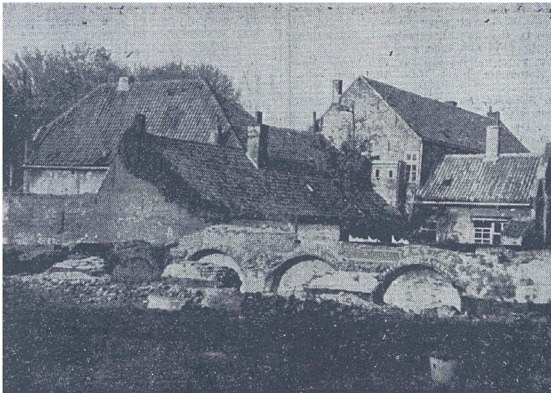
Afbeelding 2. Foto genomen in 1942 na de sloop van het bedehuis. Duidelijk zichtbaar zijn de grondbogen van de noordelijke zijmuur van het bedehuis en op de achtergrond de reftervleugel.
