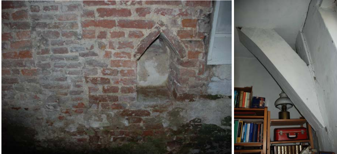
Afbeelding 5. De binnenzijde van de oostelijke zijgevel met een kaarsnis en links daarvan de positie van de thans dichtgezette muurstijl. Rechts een bewaard gebleven korbeel met muurstijl ter plaatse van de westelijke zijgevel.
