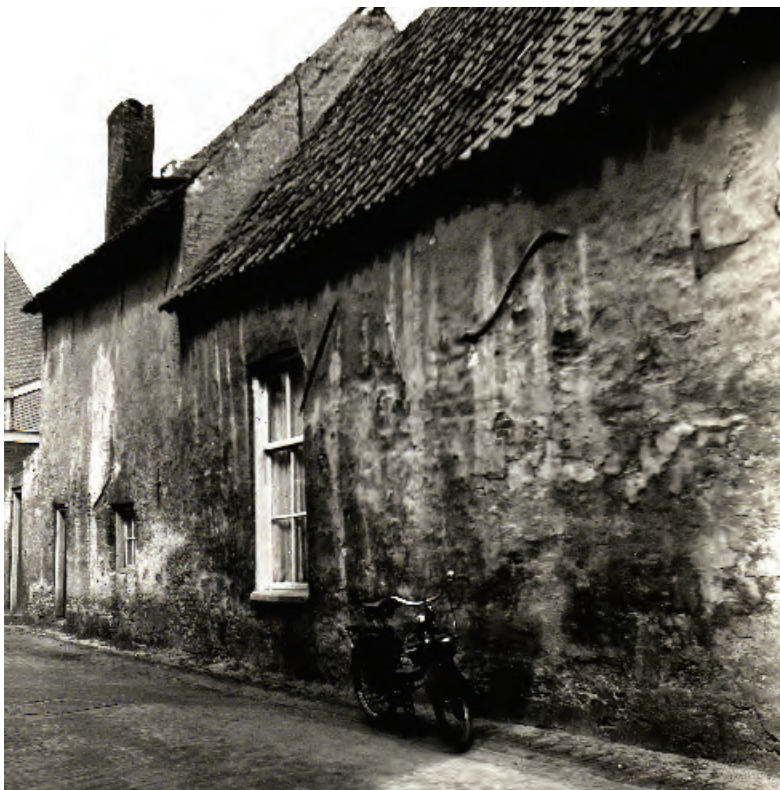
Afb.6. De linker zijgevel van het achterhuis in de jaren zestig.
