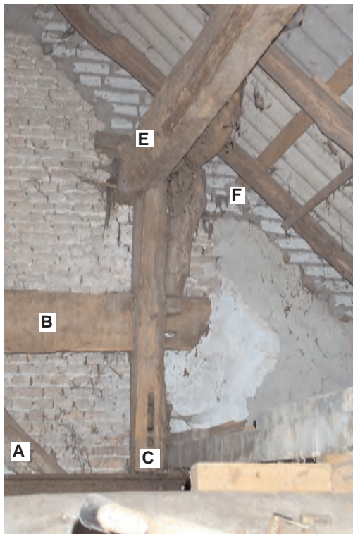
Afb. 20. Het eerste gebint bij de brandmuur. A: korbeel; B: ankerbalk; C: stijl; D: verdwenen windverband; E: fliering; F: ophoging brandmuur.
