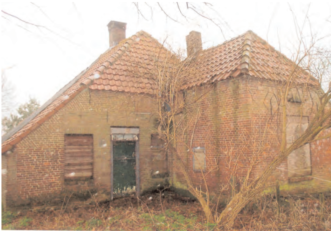
Afb. 6. Kopgevel met onder meer vernieuwd metselwerk rondom de voordeur.
