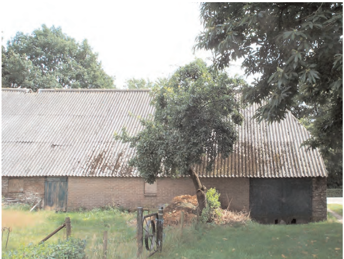
Afb. 14 en 15. De achtergevel.
