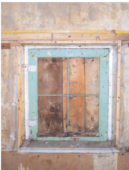
Afb. 7. Dichtgezet ijzeren draairaam.
