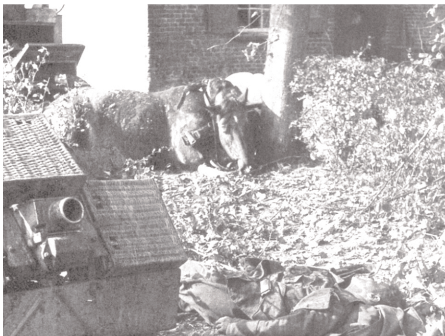
Afb. 12. Oorlogsbeeld oktober 1944. Op de achtergrond is een deel van de gevelindeling zichtbaar. Na de oorlog is een deel van de gevel vernieuwd. In: L. van Gendt, Oktober 1944. Den Bosch bevochten en bevrijd, 's-Hertogenbosch z.j., p. 47.
