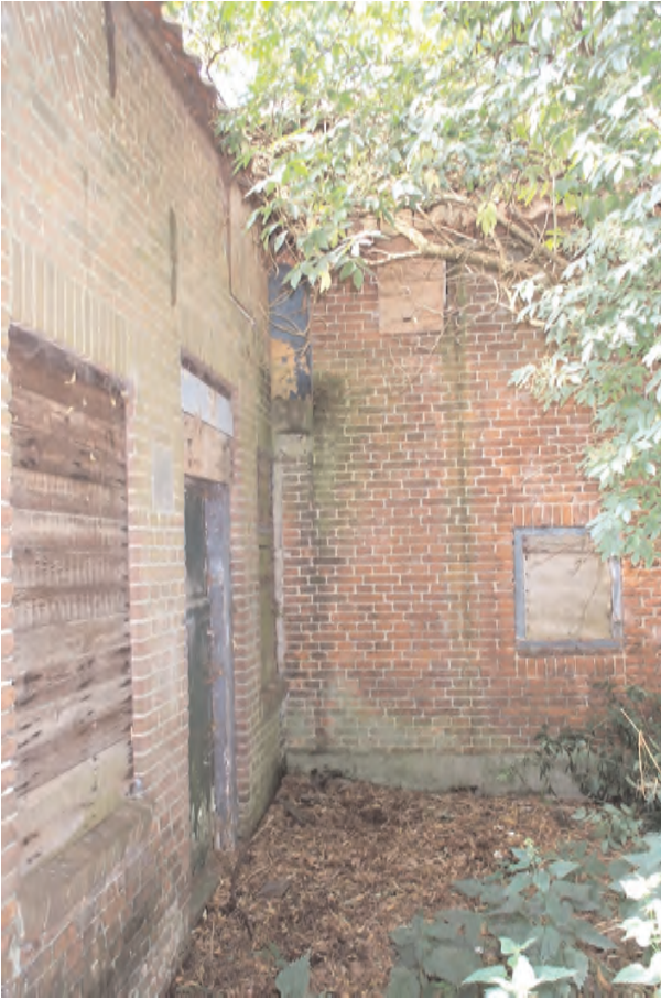
Afb. 5. De aanbouw tegen de kopgevel van het woon-gedeelte.
