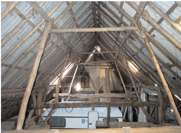
Afb. 17 en 18. Kapconstructie met gebinten.
