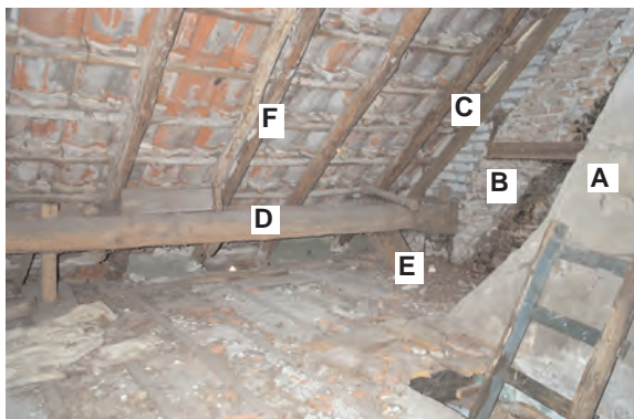
Afb. 21. A: rookkanaal; B: aftekening breder rookkanaal; C: ophoging brandmuur; D: fliering; E: windverband; F: spoor.
