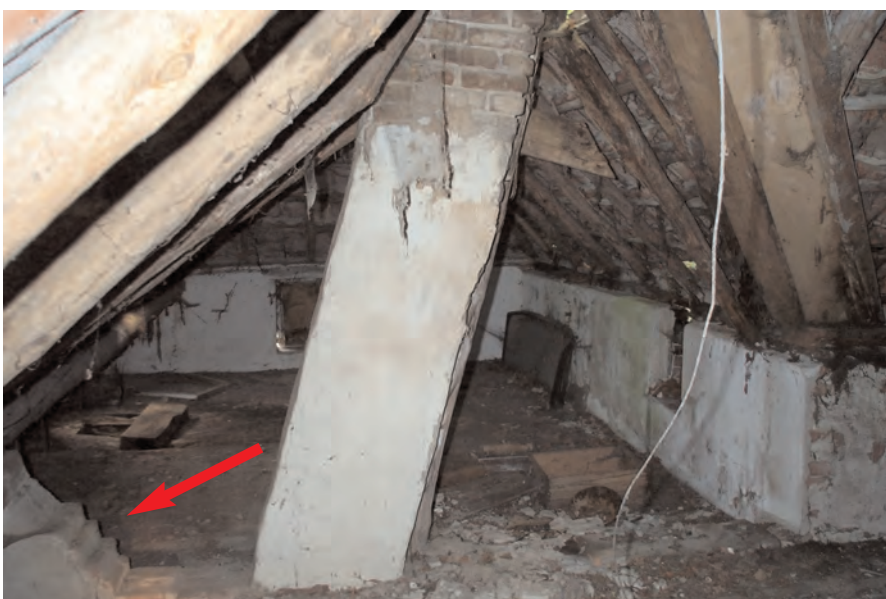
Afb. 28. Op de zolder is de doorbroken bovenzijde van de oude kopgevel te zien. Zie pijl.
