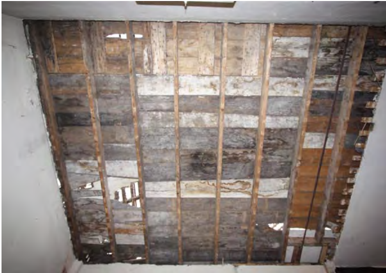
Afbeelding BG02: Hergebruikt materiaal in het eerste balkvak van de zoldervloer. Tegen de zijgevel nog een raveling ten behoeve van een verdwenen rookkanaal.
