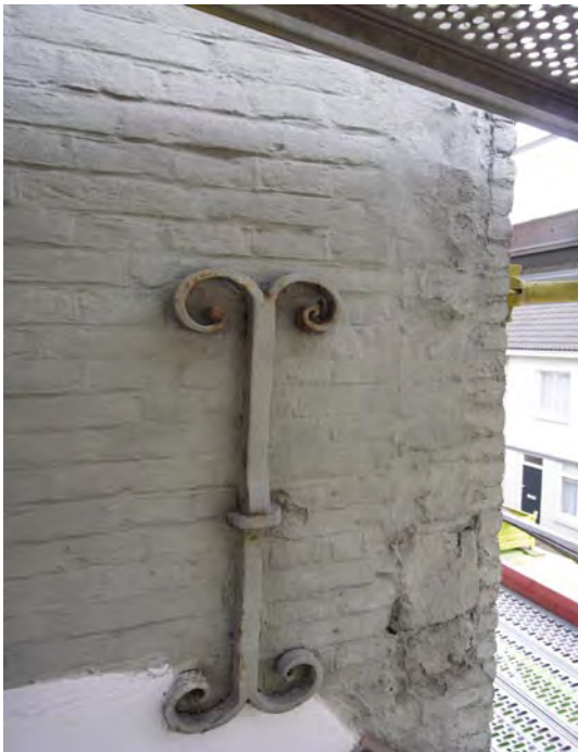
Afbeelding L04: Een sieranker op de hoek van de gevel. De verstoringen zijn niet nader te duiden.
