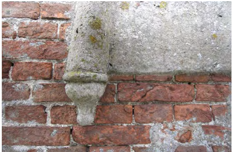
Afbeelding V02: De vensteropeningen die zijn aangebracht bij de verbouwing tot Bank van Leening hebben een versiering in cement.
