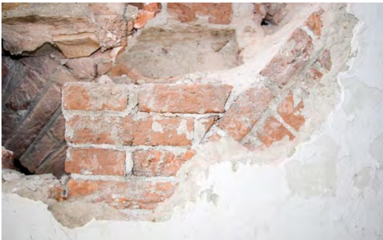
Afbeelding L10: Een detail waarop een deel van de boog van de voormalige deuropening van de glasfabriek is te zien (rechts) en links, verdiept in het vlak, een deel van een boog van een oorspronkelijke vensteropening. De boog boven de voormalige deuropening heeft de dikte van de gevel (twee stenen), de boog boven de dichtgezette vensteropening is aanzienlijk minder dik (één steen, circa 22 centimeter). Tussen de bogen is nog de afdruk te zien van de in het metselwerk aangebrachte eikenhouten ringanker.
