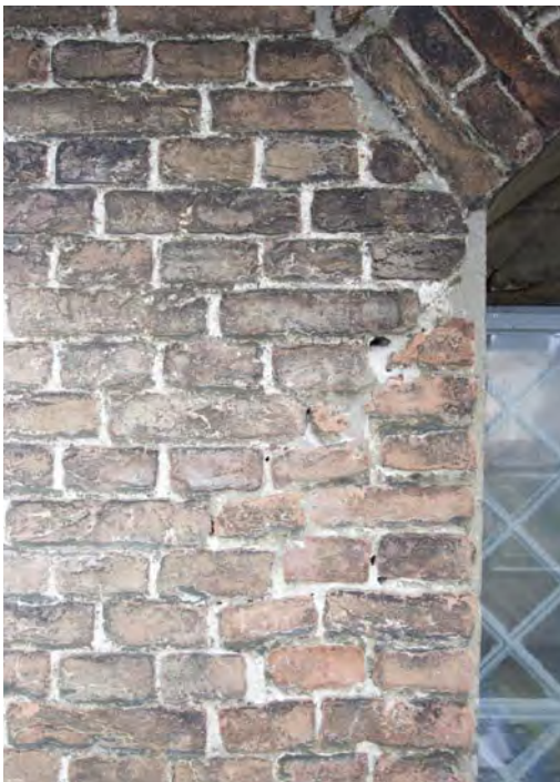
Afbeelding R04: Op enkele plekken is in de verstoring onder de later aangebrachte segmentbogen, de aanzet van een oorspronkelijke segmentboog te ontdekken.
