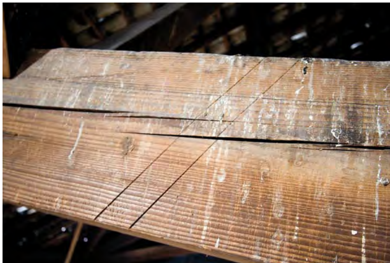
Afbeelding z04: Het telmerk II op de tussenbalk van het tweede spant, van de voorgevel geteld.
