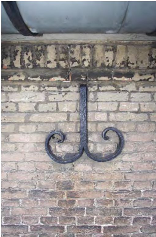
Afbeelding R06: Een detail van de afdekking van de rechter zijgevel.
