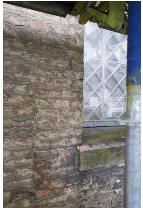
Afbeelding A02: Aan weerszijden van buitenste van drie vensters, tekenen zich bouwnaden af. Het lijkt erop dat het gebouw oorspronkelijk bredere vensters heeft gehad met een lagere onderdorpel.
