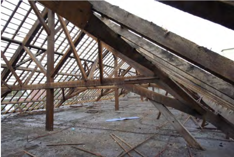
Afbeelding z08: De kapconstructie vlak voor de sloop in 2007.
