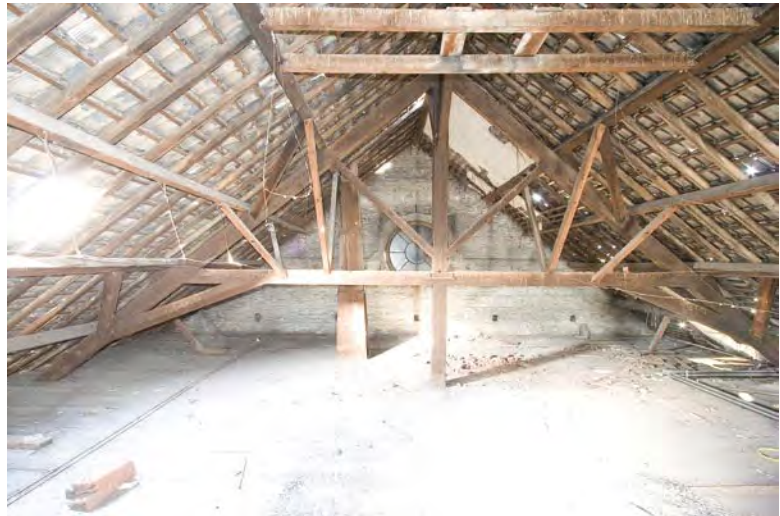
Afbeelding z01: De zolder gezien vanaf het tweede spant in de richting van de voorgevel. Boven in de foto een raveling ten behoeve van een verdwenen rookkanaal. Op de achtergrond een nog bestaand rookkanaal.
