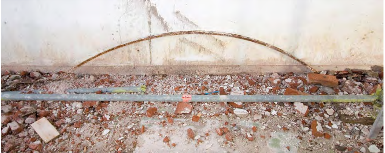
Afbeelding L12: Het uitgenomen koppelanker dat werd verwijderd boven de boog van de brede deuropening.
