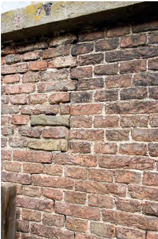
Afbeelding R02: Een detail van het muurwerk waarin zich duidelijk de dagkant van een oorspronkelijke vensteropening aftekent onder de onderdorpel van een in 1854 aangebrachte vensteropening. Het metselwerk links is overduidelijk een opvulling.
