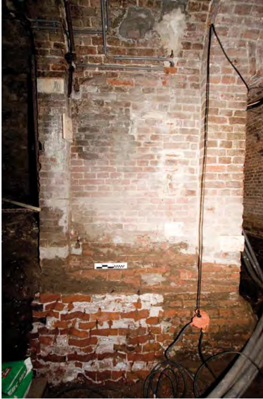
Afbeelding S01: Aanzicht B-B op de documentatie-tekening. Onder het doorbroken fundament van de voorgevel. Links de duimblokken van de oorspronkelijke toegangsdeuren van het souterrain. Het verdiepte muurwerk tussen de penanten diende om ruimte te bieden aan de naar binnen draaiende deuren. In het metselwerk is duidelijk de overgang te zien tussen het metselwerk met 10L=68 (rechts) en 10L=57.
