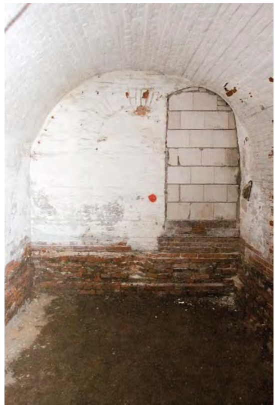
Afbeelding S11: Een volledig dichtgezette vensteropening, later doorbroken door een toegevoegde deuropening. De deuropening is aangebracht om een verbinding tot stand te brengen tussen het souterrain en het pand dat tegen de noordgevel is gezet. Opvallend is de wijze van dichtzetten van de vensteropening, afwijkend met de situatie zichtbaar op bijvoorbeeld afbeelding S02. Vermoedelijk is de opening op deze foto eerder dichtgezet, wellicht al ten tijde van de glasfabriek.
