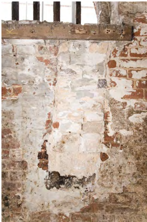
Afbeelding S14: Een dichtzetting van een sleuf onder één van de vensteropeningen in de zuidelijke zijgevel. De functie van de sleuf was niet vast te stellen.
