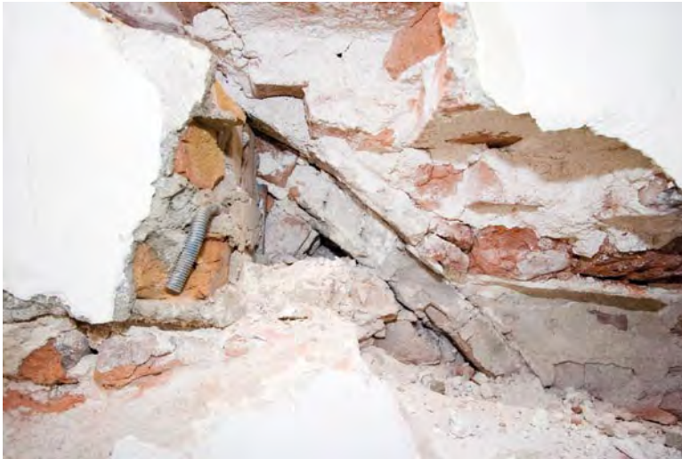
Afbeelding L09: Links op de foto een verstoring met recenter metselwerk en een verankering het gebouw in. Het deel van de boog dat zichtbaar is, heeft een afdekkende koppenlaag, wat betekent dat deze boog oorspronkelijk is.
