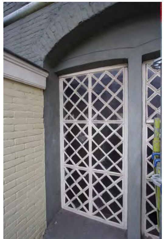
Afbeelding L05: Een van de gietijzeren ramen, aangebracht in 1854. Links het aangebouwde privaat.
