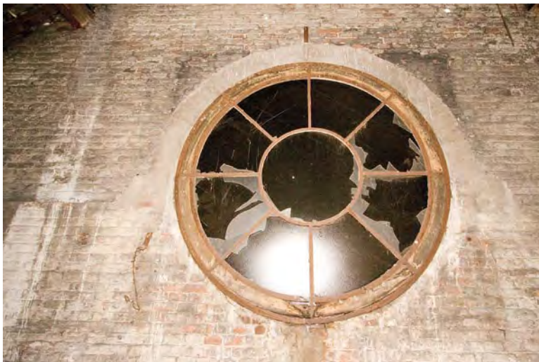
Afbeelding z07: Het in 1854 toegevoegde, gietijzeren roosvenster in de top van de voorgevel.
