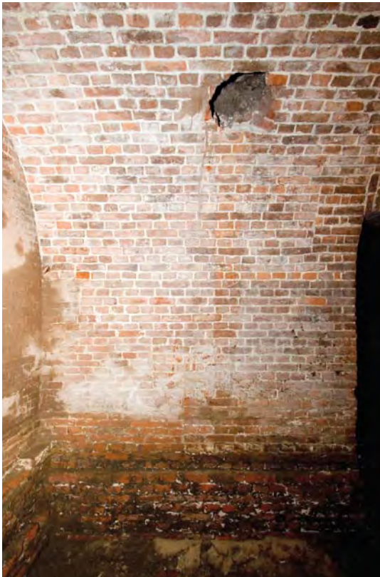
Afbeelding S03: In alle vertrekken is er een verschil aan te wijzen tussen het opgaande metselwerk van de binnenmuren (10L=68) en het opgaande werk van de gevels (10L=57). Ook is er een verschil aan te wijzen tussen het opgaande metselwerk en de gewelven, die pas na het uitzetten van het opgaande werk werden gemetseld. Uiterst rechts op de foto is goed te zien dat de segmentbogen boven de deuropeningen tussen de kelderruimten gelijktijdig zijn gemetseld met het opgaande werk, en dat daarna pas de gewelven tot stand zijn gebracht.
