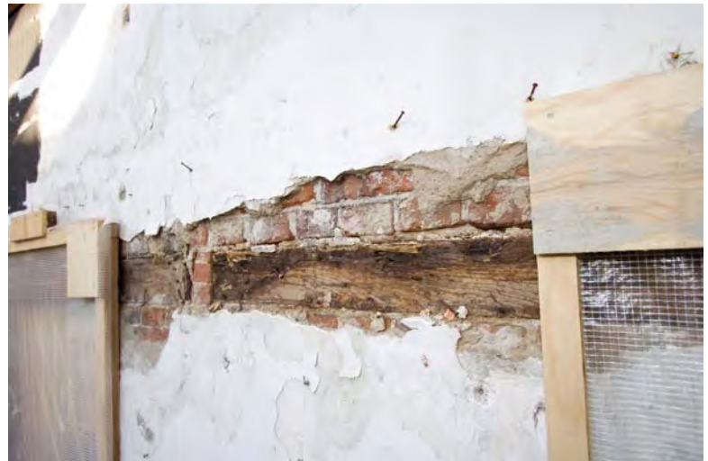
Afbeelding L13: Op de meeste plaatsen verkeert het eikenhouten ringanker nog in uitstekende staat. Hier een stuk van het anker tussen twee vensters van de Bank van Leening.
