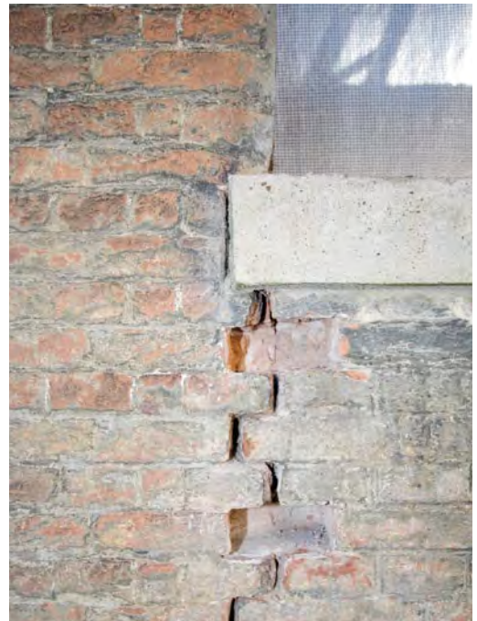
Afbeelding A03: Het middelste venster in de achtergevel heeft een bouwnaad recht onder de huidige dagkanten. Dat er sprake is van een faseverschil wordt duidelijk omdat het metselverband ter plaatse van de naad is onderbroken. Het lijkt erop dat de achtergevel oorspronkelijk drie gevelopeningen heeft gehad waarvan de buitenste breder waren dan de middelste.
