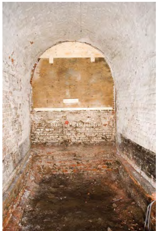
Afbeelding S15: Dichtzetting van een toegang tot het souterrain in de zuidelijke zijgevel.
