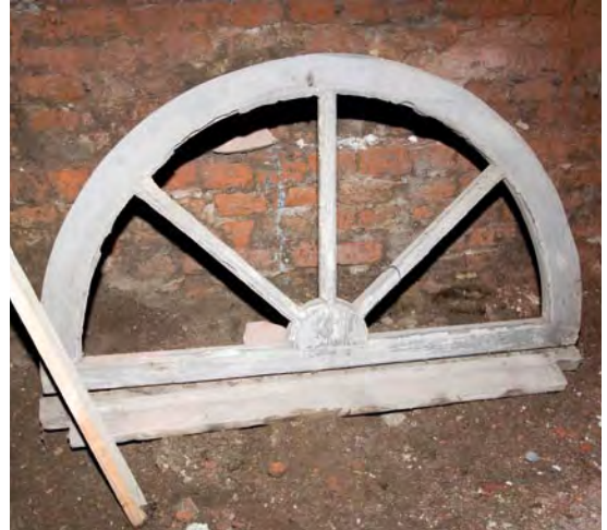
Afbeelding S17: Het negentiende-eeuws venster na verwijdering.
