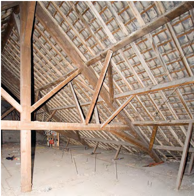
Afbeelding z02: Een deel van de kapconstructie. Hier het derde spant van de achterzijde gezien. De gordingen die zijn afgeschoord op het spantbeen zijn oorspronkelijk, de overige zijn later toegevoegd. Ook de schoren tussen de gordingen en de tussenbalk zijn toevoegingen.
