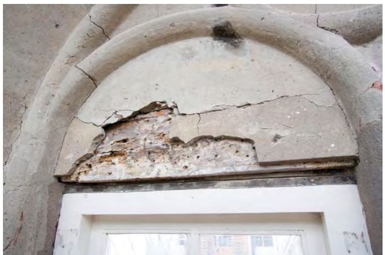
Afbeelding V03: De vensteropeningen van de Bank van Leening hebben in 1931 nieuwe vensters gekregen. Oorspronkelijk had de voor-gevel gietijzeren ramen, zoals te zien op de bouwtekening van de bestaande toestand in 1930 en zoals nog op enkele plekken behouden in de zijgevels en de achtergevel.
