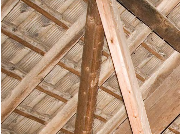
Afbeelding z03: Een takelconstructie boven het huidige luik in de zoldervloer.
