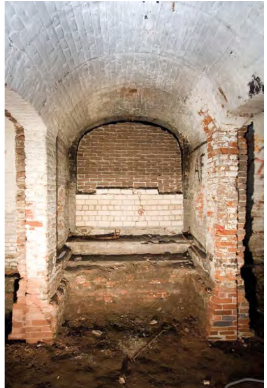
Afbeelding S13: Aan het einde van de gang een recent dichtgezette toegang tot het souterrain. Net als bij de voorgevel is hier ruimte uitgespaard voor twee naar binnen draaiende deuren.
