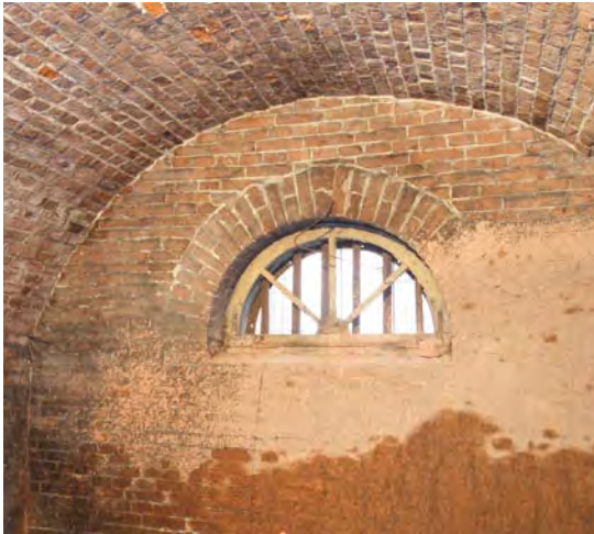
Afbeelding S16: Een oorspronkelijke vensteropening met een negentiende-eeuws venster.
