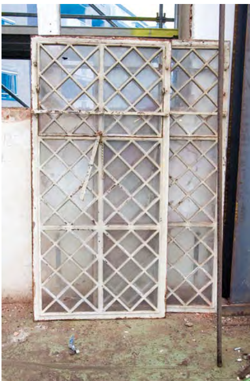
Afbeelding BG07: Twee van de gietijzeren ramen uit 1854.
