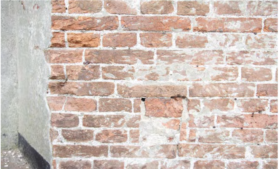
Afbeelding V04: Een detail van het metselwerk rechts van de dagkant van de voordeur, met daarin een dichtgezet balkgat, één van een gevelbrede reeks. De gaten zijn ingehakt. In de periode dat het pand deel uit maakte van de glasfabriek zijn tegen de gevel, aan weerszijden van de ingang tot het souterrain, twee aanbouwen, vermoedelijk onder een lessenaardak aangebracht. Dit wordt bevestigd door het kadastraal onderzoek. De aanbouwen ontbreken op de kaart van 1843 en worden weergegeven op de kaart van 1847.
