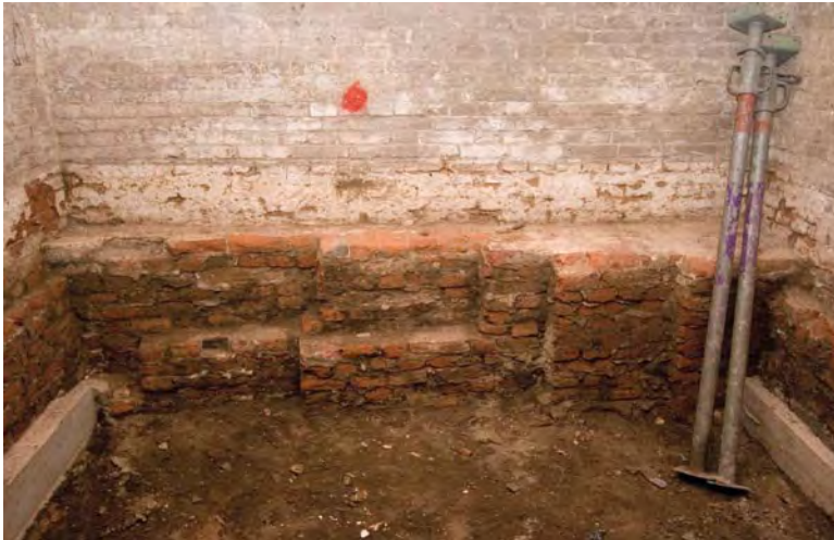
Afbeelding S05: De eerste ruimte rechts van de gang. De ongewone versnijding in de fundering van deze gevel houdt mogelijk verband met de functie van keermuur van de Binnen Dieze, die oorspronkelijk langs de rechter zijgevel van het gebouw ging.
