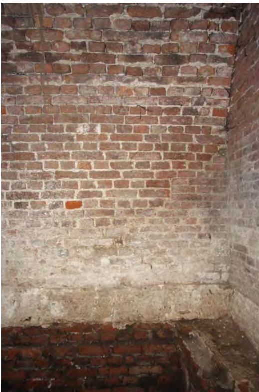
Afbeelding S07: Ook hier de overgang tussen de twee soorten metselwerk. De gewelven staan niet in verband met het metselwerk van de gewelven.
