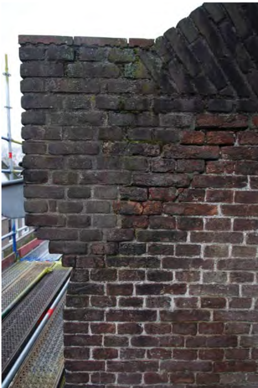
Afbeelding A01: De geveltop is volledig vernieuwd. Hier in detail het in 1930 aangebrachte schouderstuk.
