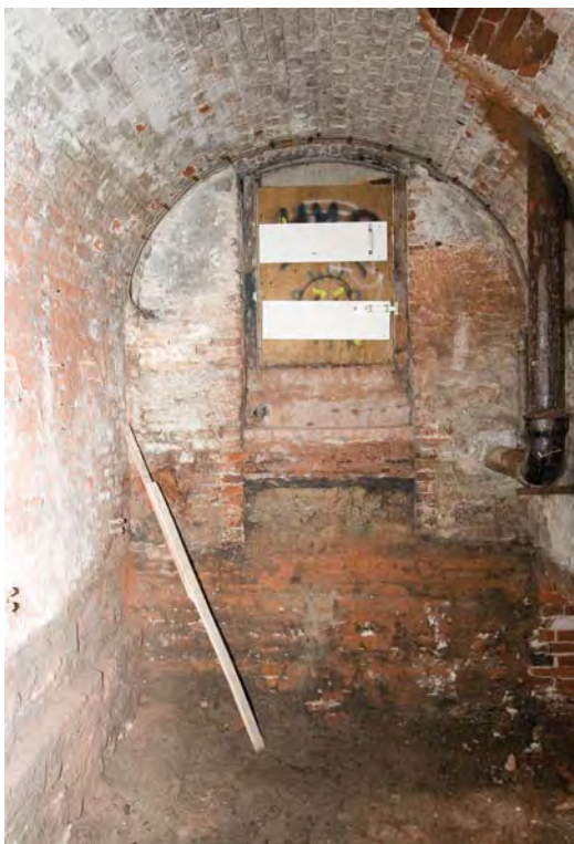
Afbeelding S09: Oorspronkelijk een brede toegang tot het souterrain vanaf het binnenterrein van de glasfabriek. Vermoedelijk in 1854 dichtgezet met uitsparing van een deur. In het metselwerk is een restant te zien van een bakstenen trap.
