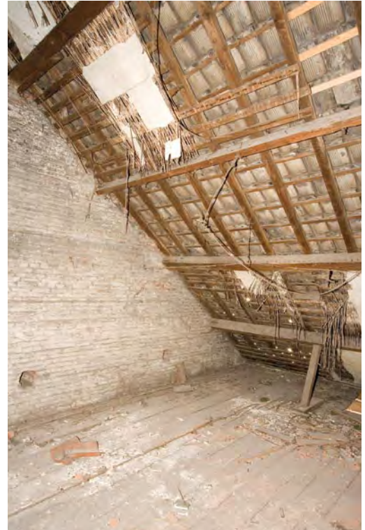
Afbeelding z06: Een deel van de kap was afgewerkt met stuc op riet.
