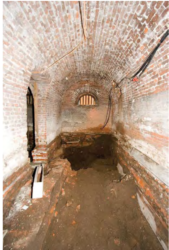
Afbeelding S04: De eerste ruimte rechts van de gang met de speciebaarden van het vernieuwde gewelf. Links op de foto een deel van het aangetroffen fundament.
