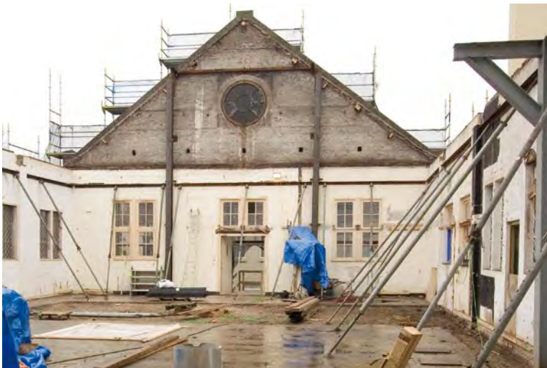
Afbeelding BG06: De begane grond in de richting van de voorgevel. In de voorgevel tekenen de vernieuwingen zich goed af door het kleurverschil in baksteen. Zo is goed te zien dat het roosvenster een toevoeging is, en ook dat de geveltop een vernieuwing of een toevoeging is.
