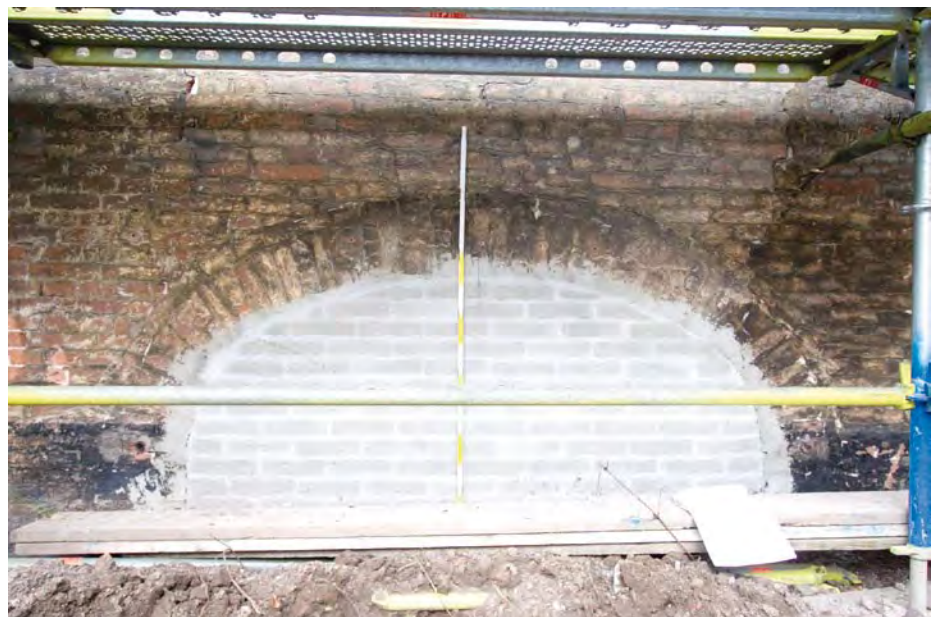
Afbeelding A04: De achtergevel heeft oorspronkelijk ook een toegang tot het souterrain gehad. De korfboog heeft een afdekkende koppenlaag.
