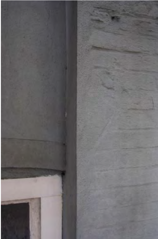
Afbeelding L06: Net als in de rechter zijgevel is hier duidelijk te zien dat de vensteropening waarin het rondvenster is gevat, is vergroot nadat het pand in gebruik werd genomen als Bank van Leening. Op de foto is de boogaanzet van de vensteropening uit 1854 nog te zien.
