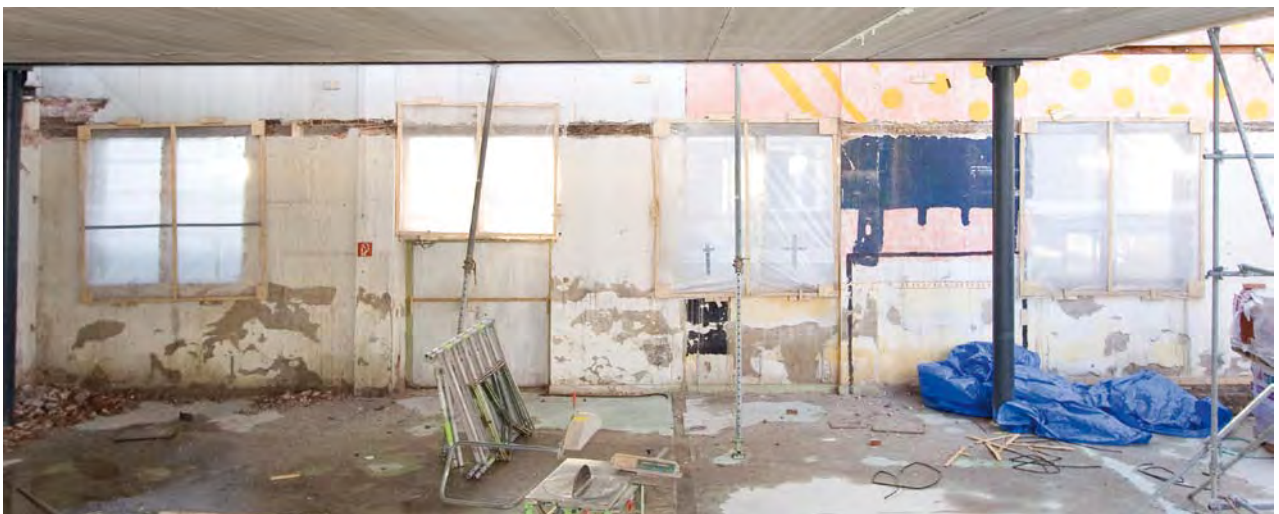
Afbeelding L14: Op een overzichtsfoto van de rechter zijgevel is het ringanker te zien ter hoogte van de bovendorpels van de vensteropeningen van de Bank van Leening.
