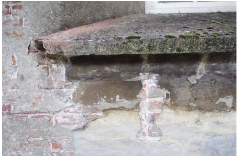
Afbeelding V01: Onder de vensters zijn de dagkanten van de oorspronkelijke vensteropeningen van de Glasfabriek aangetroffen.
