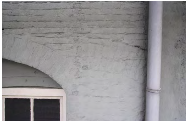
Afbeelding L03: Van de tweede oorspronkelijke segmentboog is slechts een fragment bewaard. Op de boog sluit tegenwoordig de segmentboog van een in 1854 aangebrachte vensteropening aan. Het venster, waarvan een fragment is te zien, dateert uit 1931.
