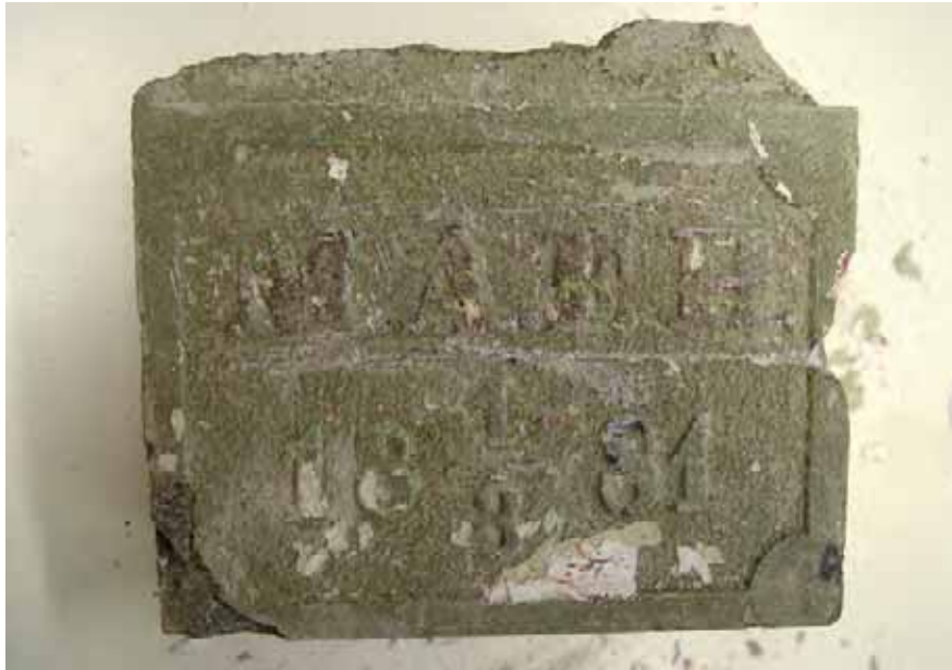
Afb. 84 De gevelsteen rechts van de bouwnaad tussen de voorgevels van de panden Stooftstraat 3 en Stooftstraat 5. De steen is met portlandcement gemetseld in een met kalk gevoegde voorgevel van het pand Stooftstraat 3 en herinnert aan het jaar 1881.
