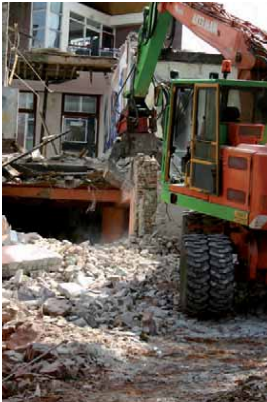
Afb. 34 De anderhalfsteens dikke muur tussen de panden Stoofstraat 3 en 5 tijdens de sloopectiviteiten, gezien in de richting van de voorgevel.
