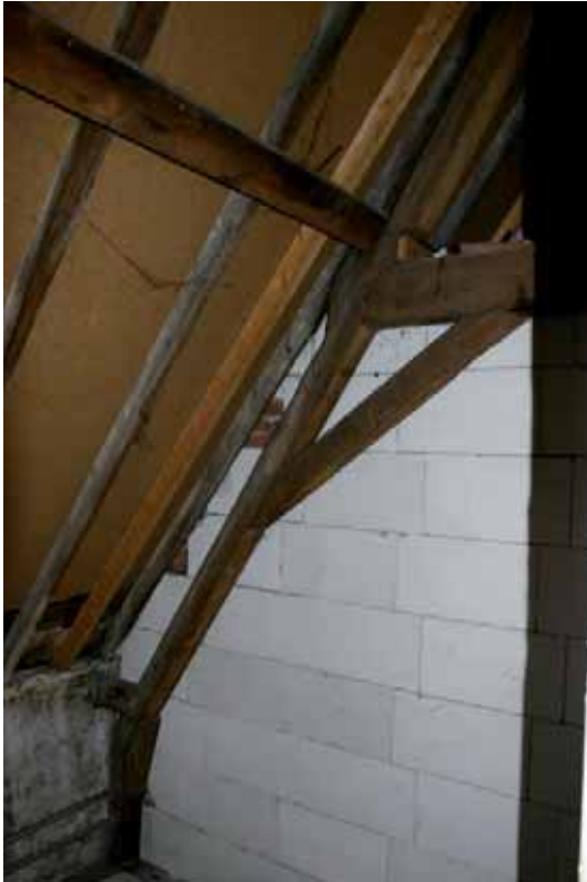
Afb. 21 Onbewerkt spantbeen van een van de achttiende-eeuwse kaspanten en de beschoten kap van Stoofstraat 3.
