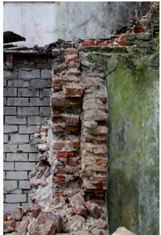
Afb. 70 Een detail van de achtergevel met nogmaals duidelijk de beklamping.
