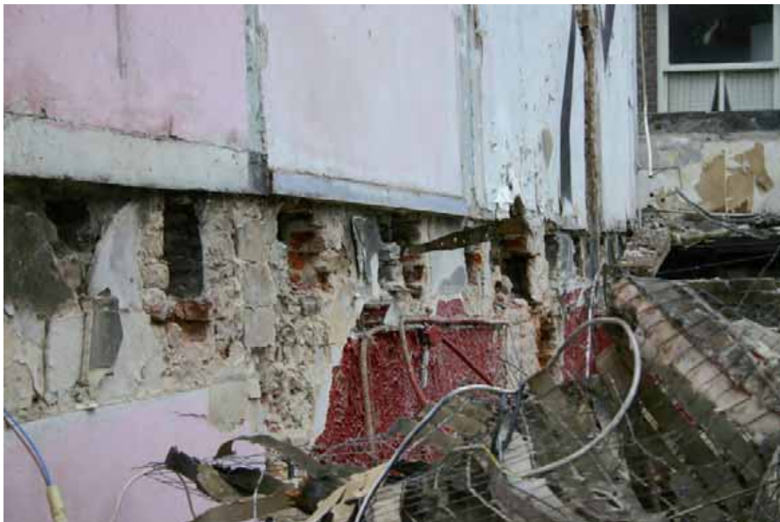
Afb. 13 Een detail van de rechter zijgevel met balkgaten waarvan een aantal is ingehakt.
