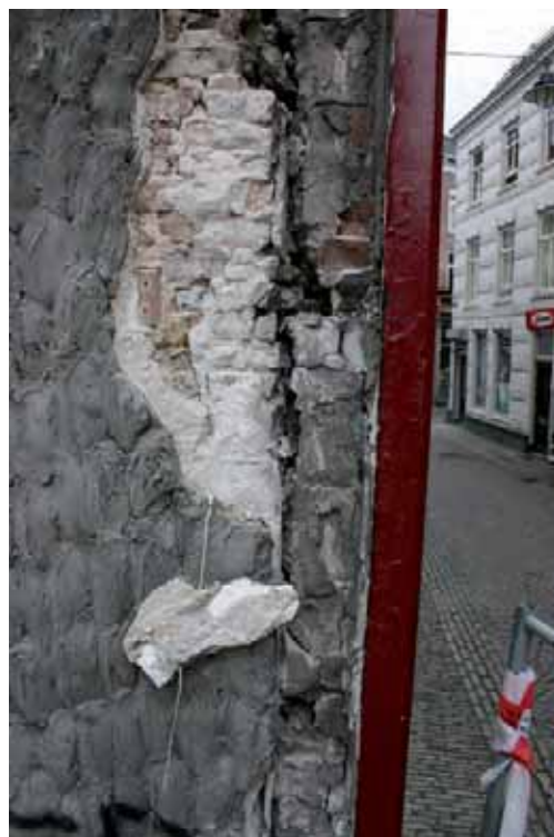
Afb. 14 Een detail waaruit op te maken is dat de gesloopte voorgevel was ingekast in de oudere zijmuur.
