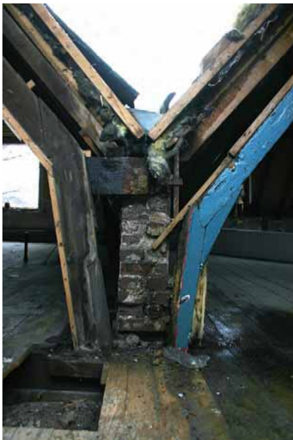
Afb. 24 Een detail van de doorsnede van de muur tussen Stoofstraat 3 en Stoofstraat 5 met duidelijk het verschil tussen de achttiende-eeuwse kapconstructie van nummer 3 en de negentiende-eeuwse kapconstructie van nummer 5. De negentiende-eeuwse bakstenen in de tussenmuur wijzen er op dat de achttiende-eeuwse kaspanten hier zijn hergebruikt, hetgeen wijst op een ophoging van het pand met huisnummer 3.
