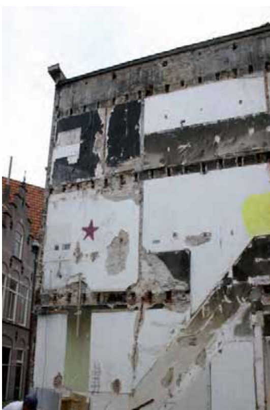
Afb. 31 Het linkerdeel van de zijmuur tussen de panden Stoofstraat 5 en 7-9 gezien vanaf het perceel van het eerstgenoemde pand. Goed zichtbaar zijn de loop van de gesloopte trap en de balkkopopleggingen van de negentiende-eeuwse enkelvoudige balklaag in de zijmuur.
