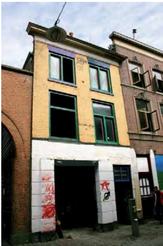
Afb. 52 De voorgevel van het pand Stoofstraat 11-13 anno 2005.
