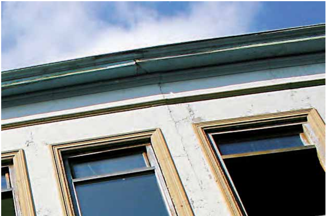
Afb. 9 De fasering tussen de voorgevels van Stoofstraat 3 en 5 wordt duidelijk door de aftekening van een verticale naad in het pleisterwerk en de aansluiting van de kroonlijst van nummer 5 op de oudere lijst van nummer 3, die oorspronkelijk ter linkerzijde gekornist was.
