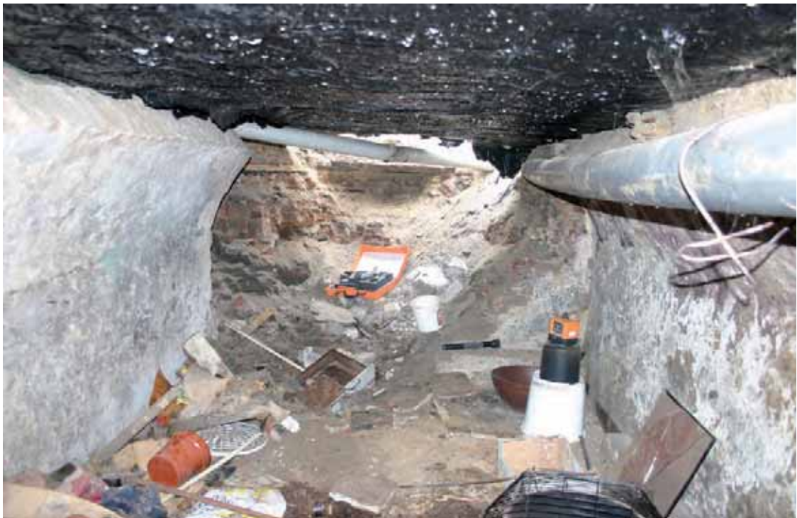
Afb. 17 Zicht in de grootste kelder nog voordat de moderne vloer op de begane grond is verwijderd. De kelder heeft nog restanten van het achttiende-eeuwse tongewelf.
