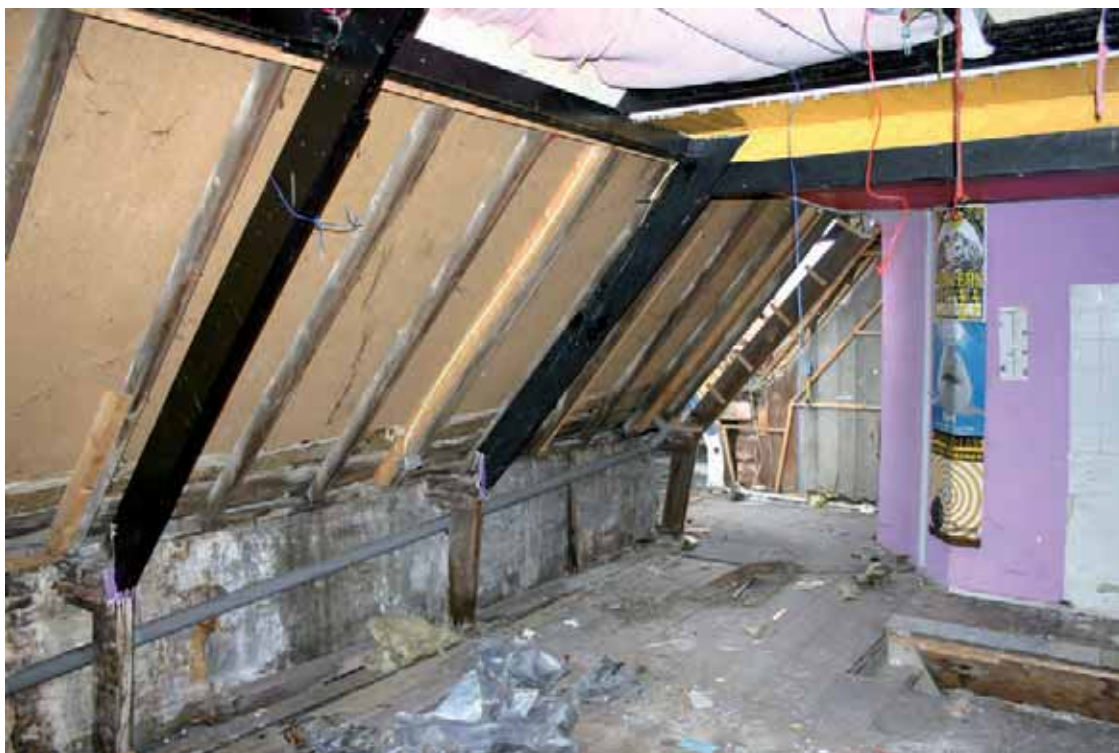
Afb. 41 De kapconstructie gezien in de richting van de voorgevel na het verwijderen van de houten aftimmering evenwijdig aan de borstwering.
