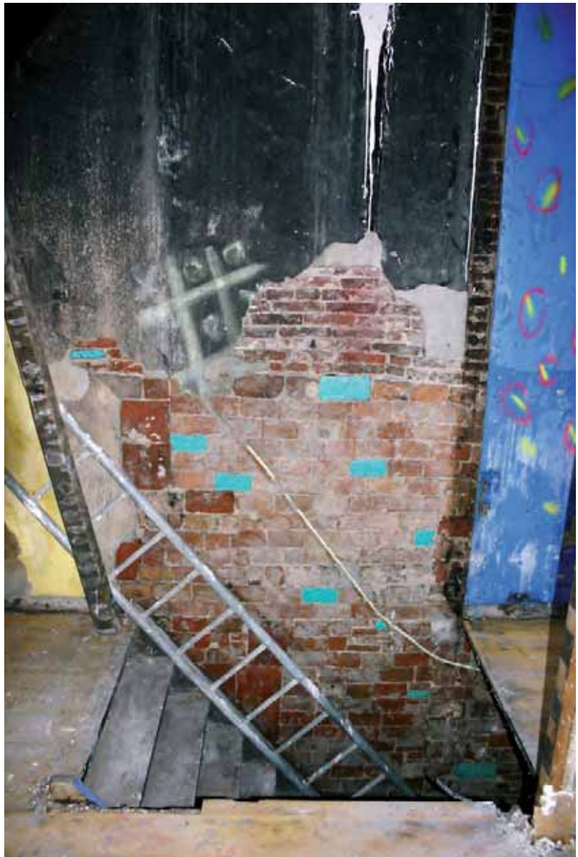
Afb. 62 De rechter zijmuur op het niveau van de vloer van de eerste verdieping. Ter plaatse van de steektrap is het muurwerk uitgevlakt door op de kant geplaatste bakstenen.
