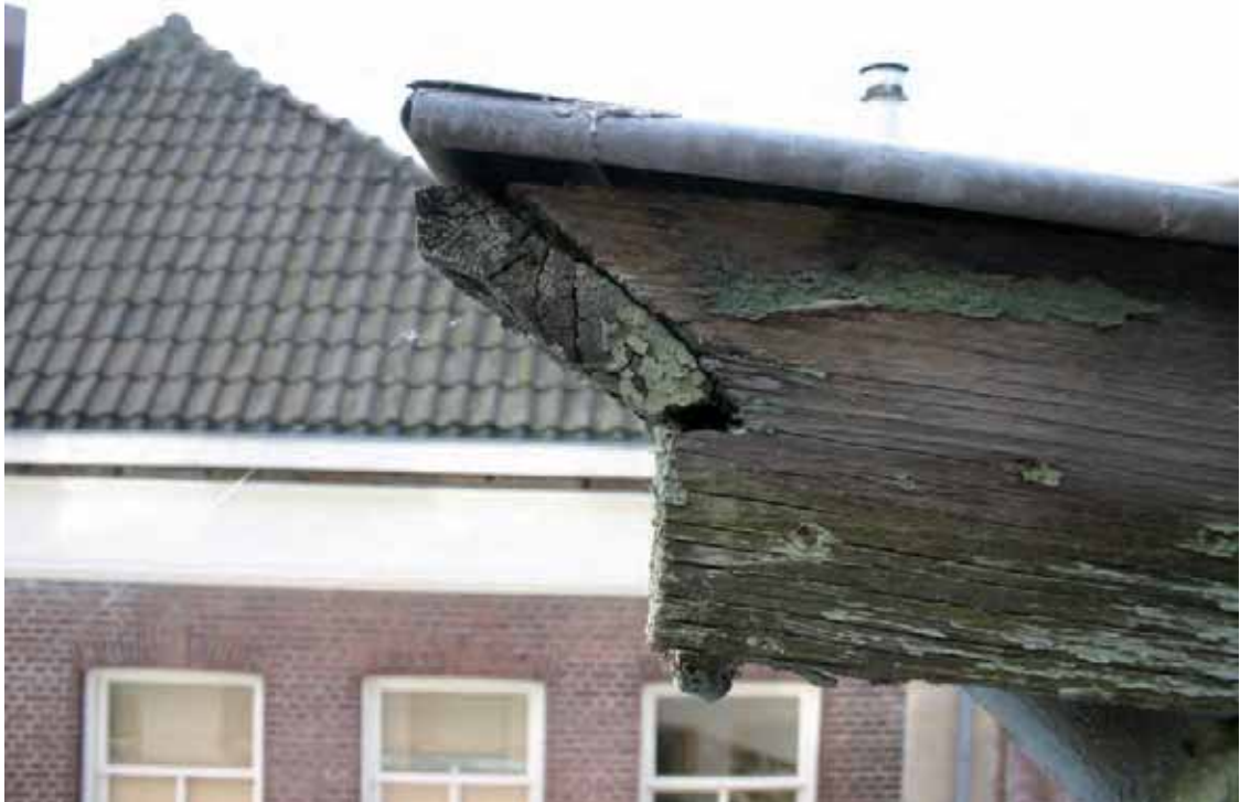
Afb. 27 Een aanzicht van de kroonlijst van de voorgevel van het pand Stoofstraat nummer 5.
