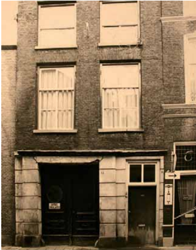
Afb. 54 Een oude foto van een deel van de voorgevel van het pand, nog met de oude vensters en deuren, de kroonlijst boven de pui is al wel verdwenen.
