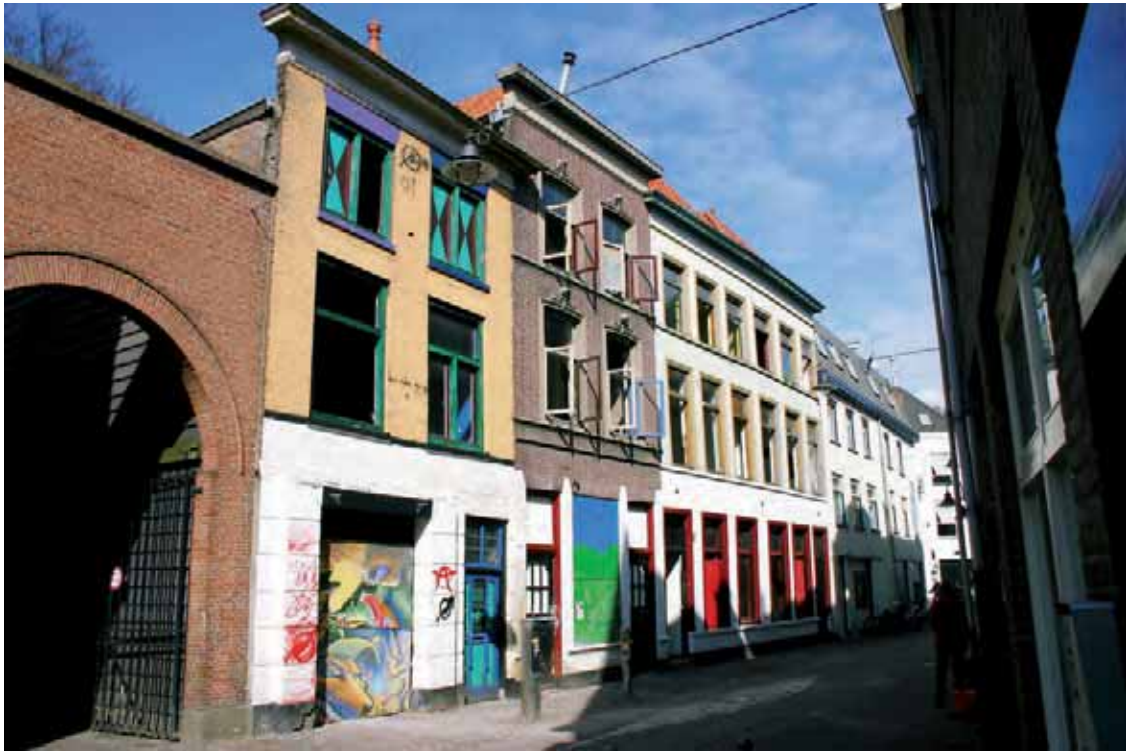
Afb. 2 De gevels van de panden. Van rechts naar links Stooftstraat 3, 5, 7-9 en 11-13.
