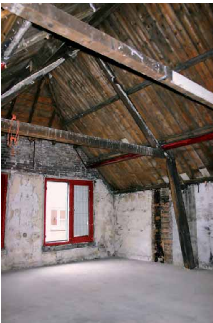
Afb. 64 De provisorische kapconstructie samengesteld met behulp van ouder materiaal.
