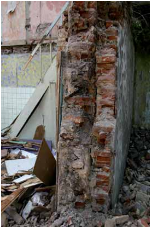
Afb. 69 De achtergevel van het inmiddels grotendeels gesloopte achterhuis in doorsnede, waarbij de beklamping aan de buitenzijde goed zichtbaar is.
