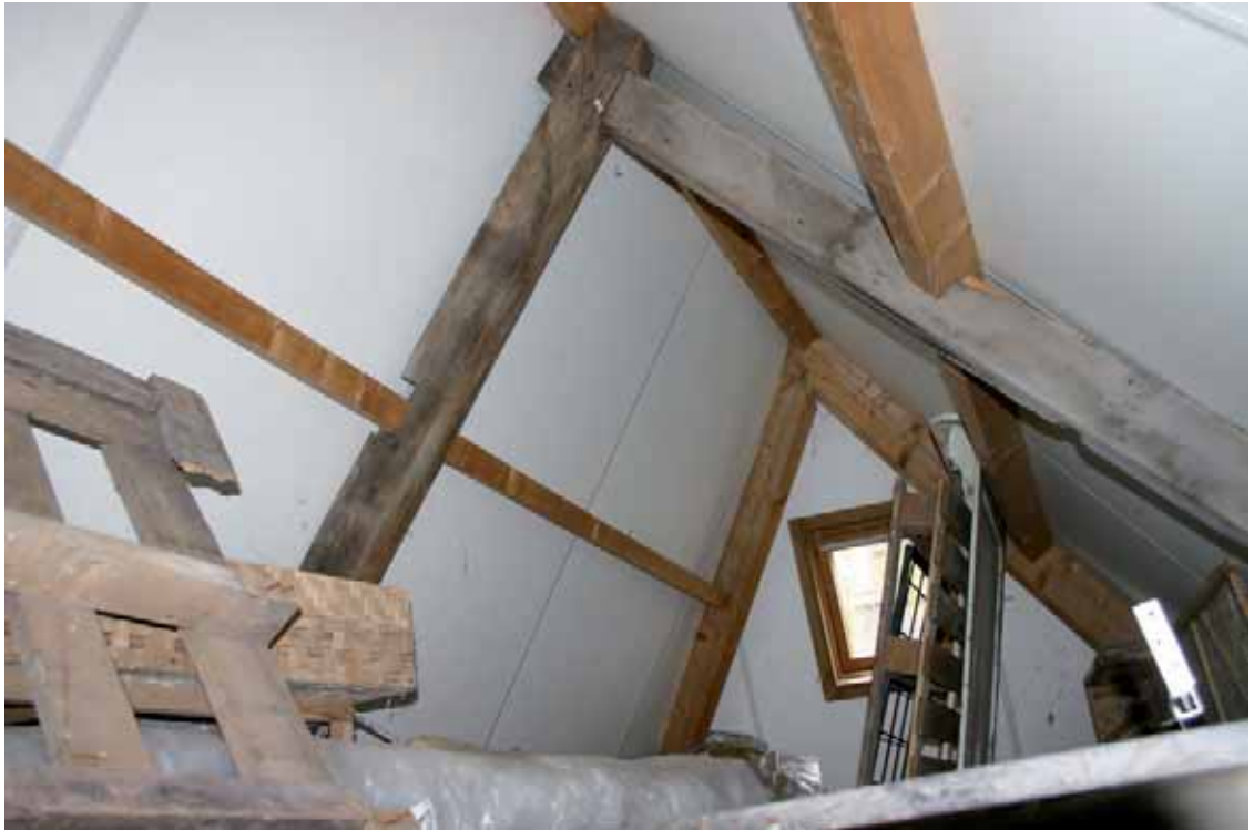
Afb. 68 De kapconstructie gezien richting de Snellestraat. Het spant op de voorgrond is negentiende-eeuws.
