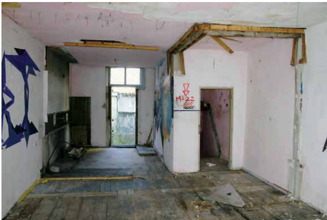
Afb. 15 De eerste verdieping gezien in de richting van de achtergevel met rechts het traphuis en op de vloer de afdruk van een verdwenen gangmuur.
