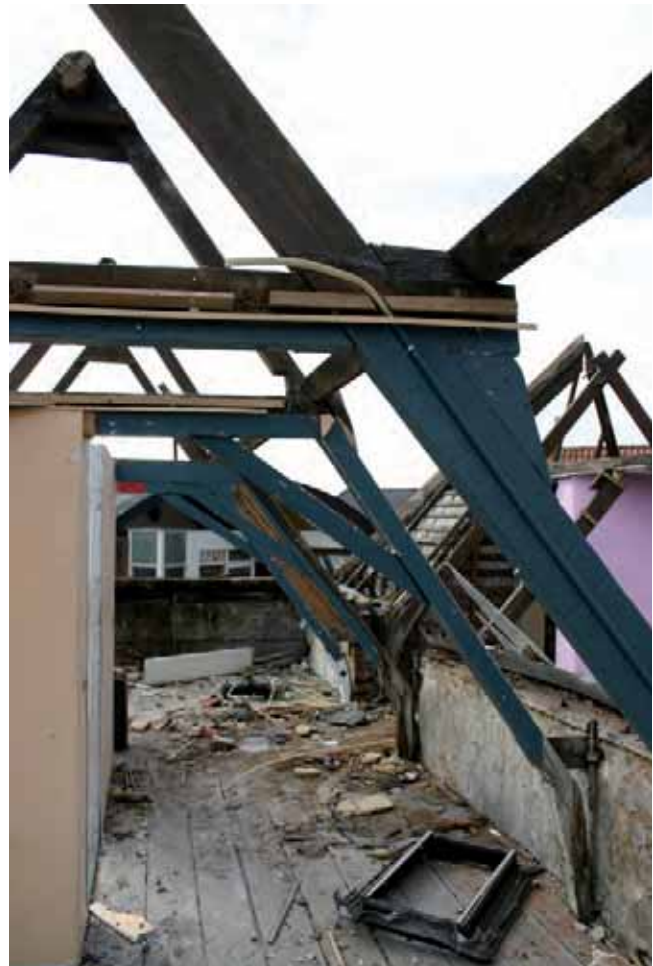
Afb. 20 Zicht op een deel van de kapconstructie van het pand Stoofstraat 3. Op de voorgrond het laat negentiende-eeuwse kaspant met de halfhouts aan de spantbenen gekoppelde trekbalk en op de achtergrond de achttiende-eeuwse kaspanten met de kenmerkende korbeels en de geknikte spantbenen.
