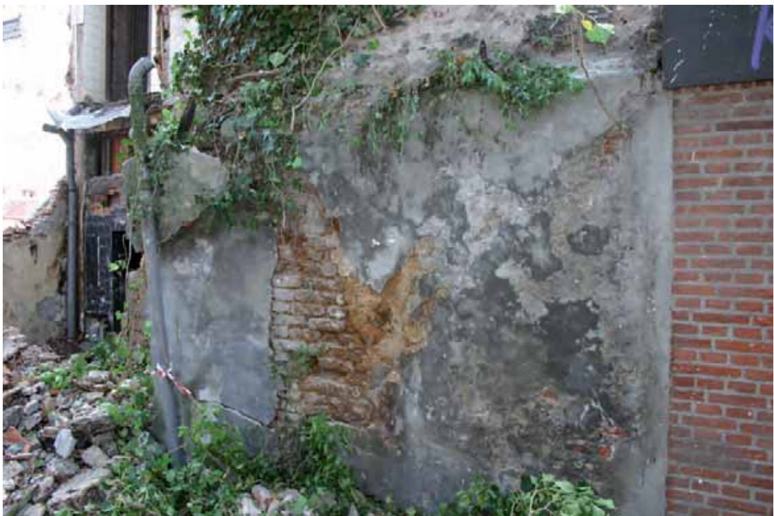
Afb. 48 Een detail van de muur op de perceelgrens van het pand Stoofstraat 7-9 met daarin bakstenen die mogelijk nog uit de zestiende eeuw dateren.
