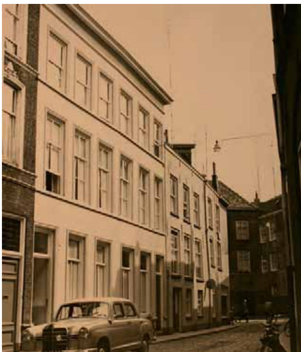
Afb. 8 De situatie in de jaren zeventig van de afgelopen eeuw. Het grote gebouw op de voorgrond omvat de panden Stoofstraat 3 en Stoofstraat 5.
