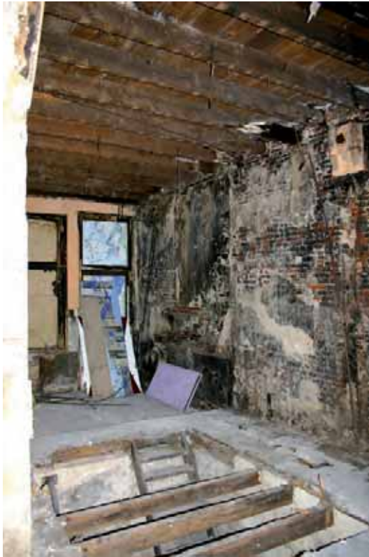
Afb. 49 Het voorste deel van de linker zijmuur met daarin opgelegd de enkelvoudige balklaag van de verdiepingsvloer. Op de voorgrond de kelder onder het pand, eveneens voorzien van een enkelvoudige balklaag. De zijmuur heeft bakstenen die wijzen op een bouwtijd vóór het jaar 1600.
