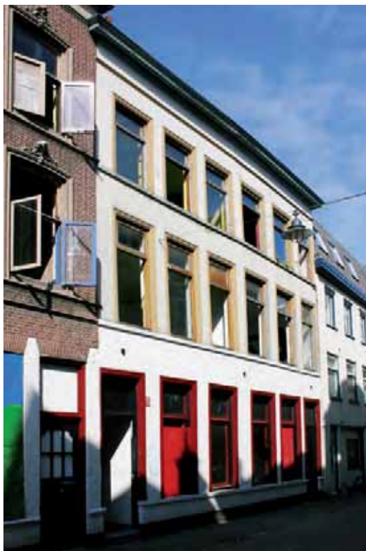
Afb. 25 Huidige situatie met op de voorgrond het pand Stoofstraat 5, waarvan de voorgevel een geheel lijkt te vormen met de voorgevel van het pand Stoofstraat 3.
