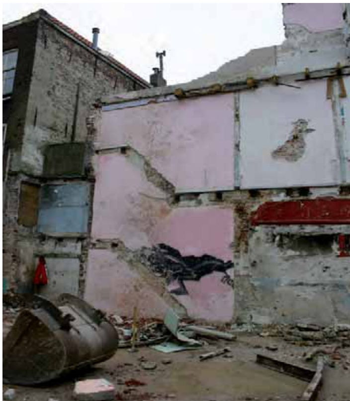
Afb. 12 De rechter zijgevel met links de sporen van de gesloopte bordestrap.
