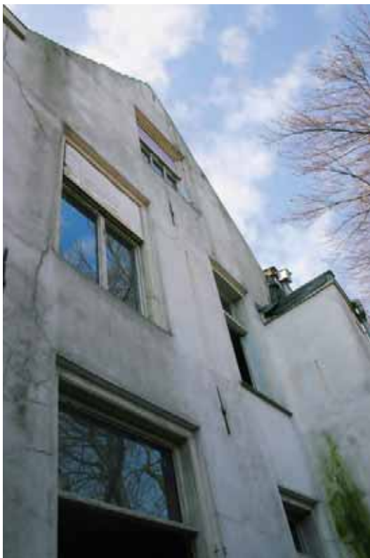
Afb. 28 De negentiende-eeuwse bepleisterde achtergevel van het pand Stoofstraat 5 met rechts op de foto het aangebouwde privaat.
