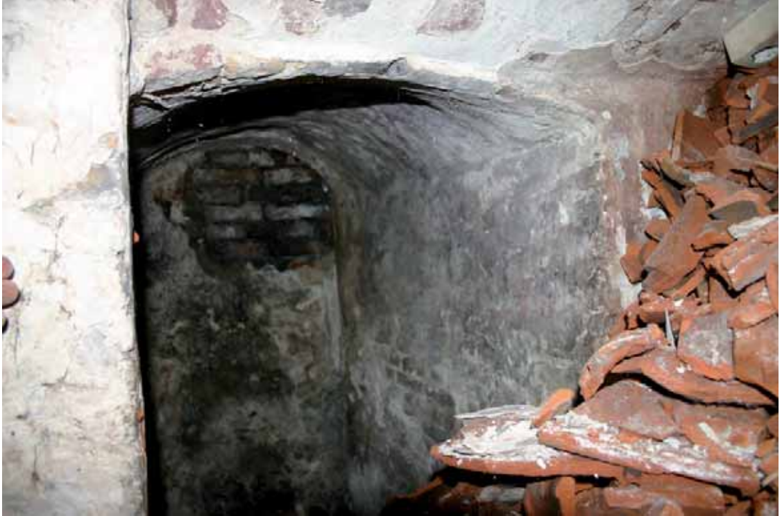
Afb. 18 Zicht in een tongewelfde keldernis onder het voormalige pand Stoofstraat 3.
