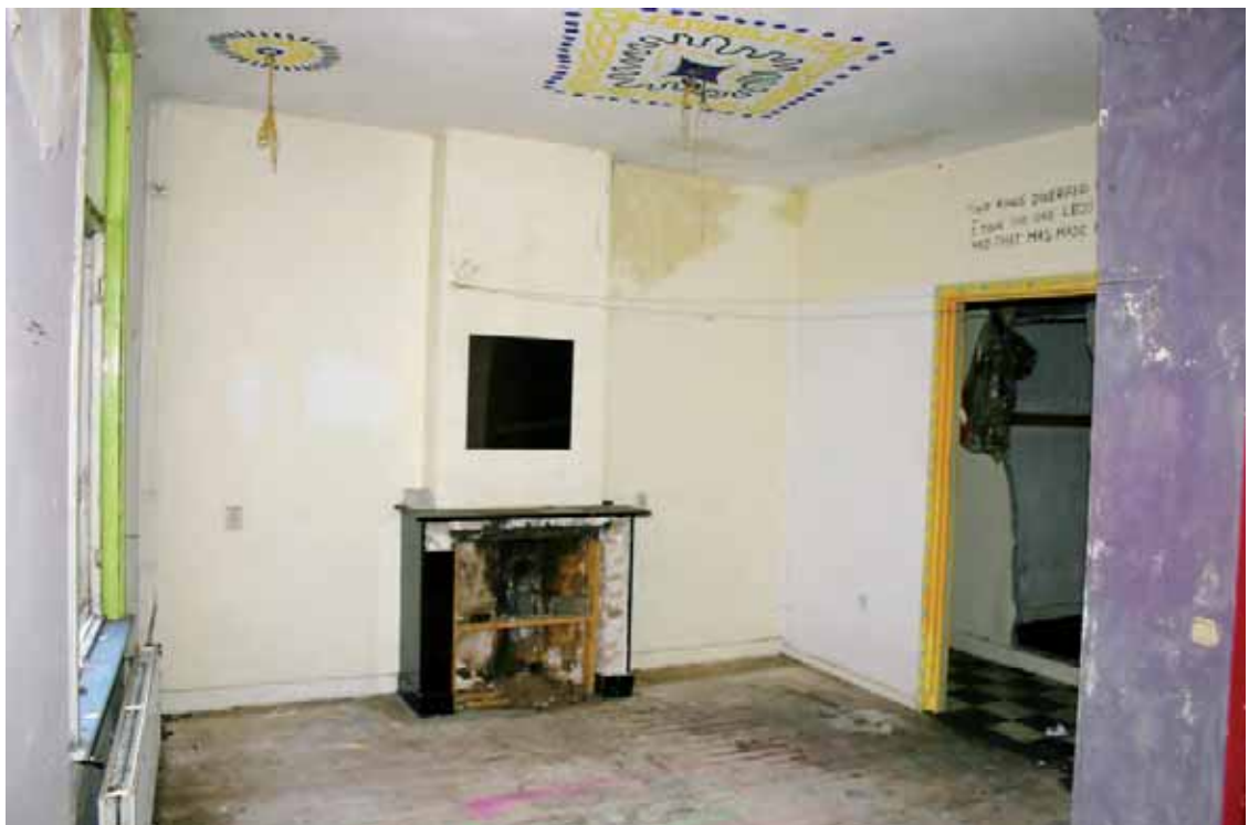
Afb. 38 Een hardstenen schouw in de achterkamer van de eerste verdieping.
