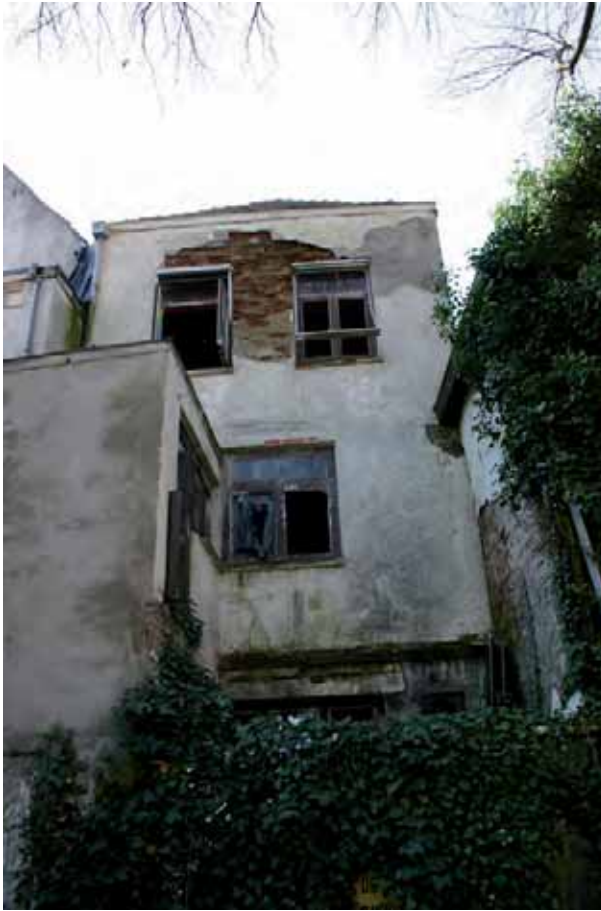
Afb. 46 De deels bepleisterde achtergevel van Stoofstraat 7-9 met de aanbouw op de begane grond en de verdieping. Rechts op de foto de tweelaags aanbouw achter het gebouw Stoofstraat 11-13.
