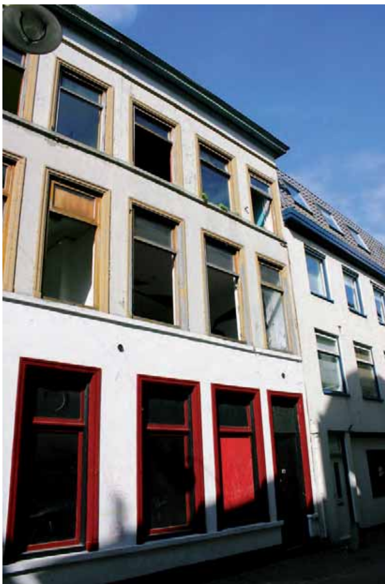
Afb. 10 De voorgevel van het pand Stoofstraat 3.
