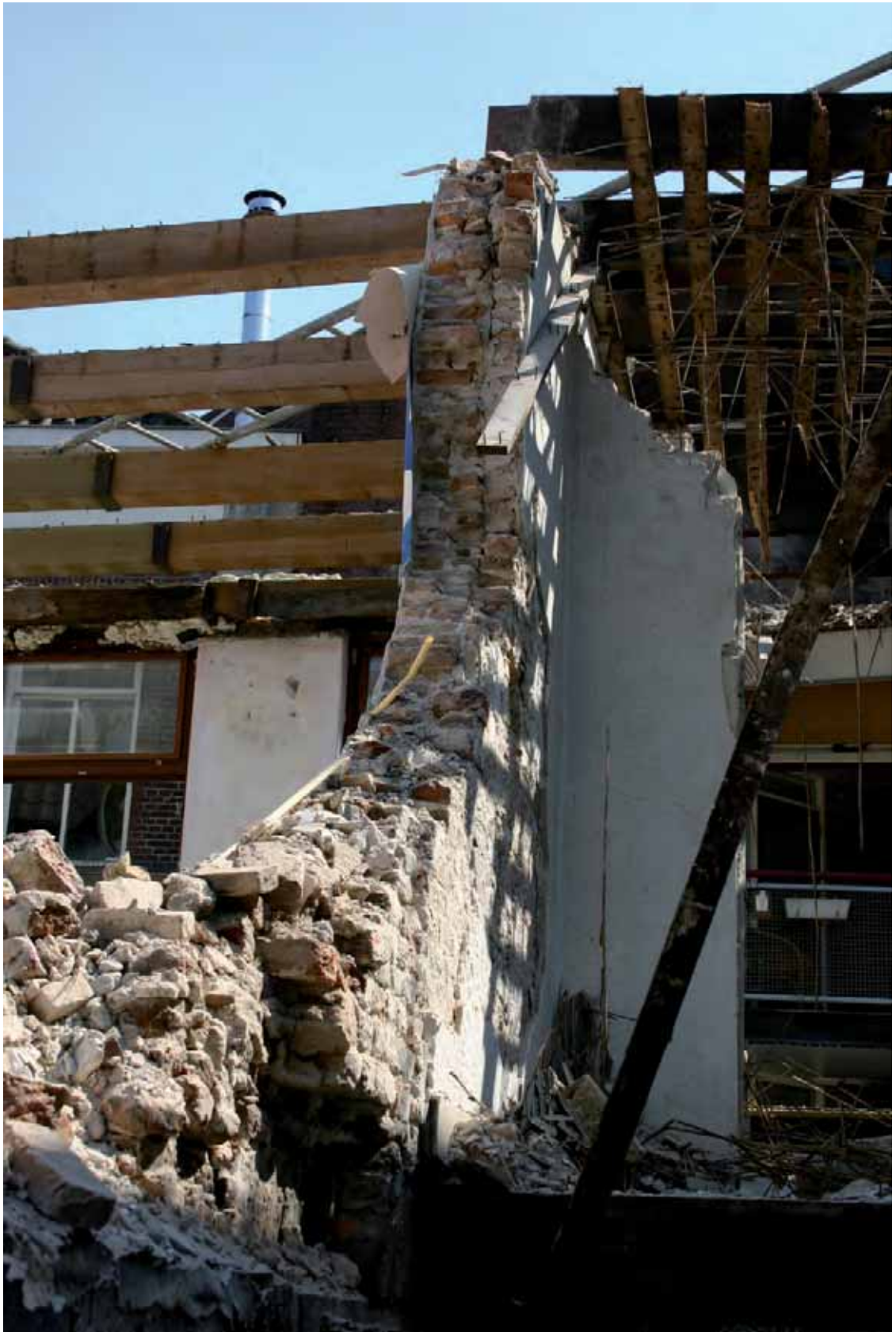
Afb. 33 De doorsnede van de muur tussen de panden met de nummers 3 (l) en 5 tijdens de sloop. Aan weerszijden zijn balken van de gesloopte vloeren in de muur opgelegd. Aan de zijde van Stoofstraat 5 is de muur beklampt ter versterking van de oplegging. Dit duidt erop dat de balken van de vloer van Stoofstraat 5 zijn aangebracht in een bestaande muur, de zijmuur van het pand Stoofstraat 3.
