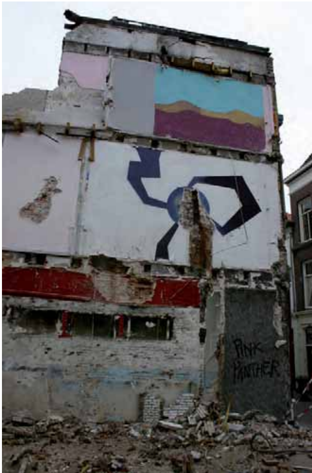
Afb. 11 De rechter zijgevel met daarin duidelijk zichtbaar de achttiende-eeuwse balklagen van de eerste- en de tweede verdiepingvloer en de negentiende-eeuwse balklaag van de vloer op de zolder. Op het niveau van de voormalige eerste verdieping is een rookkanaal horende bij een verdwenen schouw zichtbaar.
