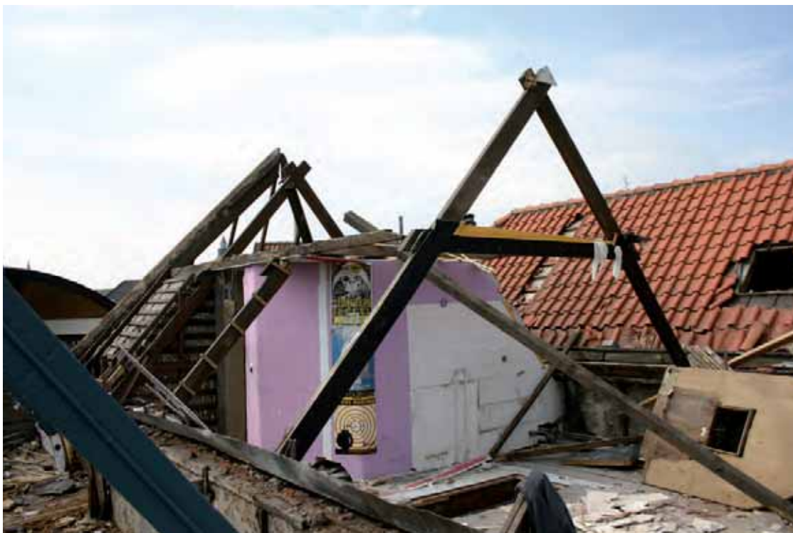
Afb. 42 Overzicht van de kapconstructie tijdens de sloop, gezien in de richting van de voorgevel.
