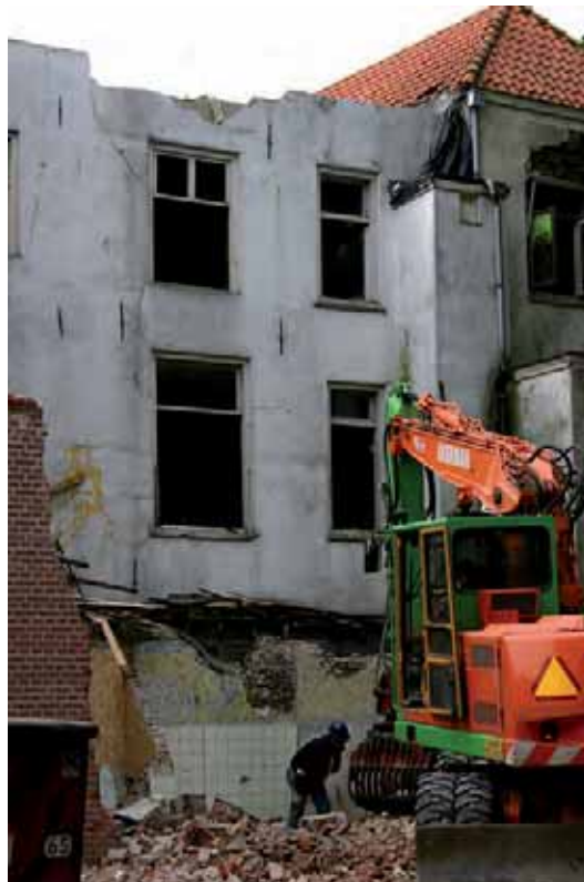
Afb. 29 Dezelfde achtergevel tijdens de sloopwerkzaamheden. De achtergevel is op de begane grond twintigste-eeuws. De gevelindeling is vermoedelijk gewijzigd na het aanbouwen van de privaten waarbij de vensters in de rechter vensteras zijn gewijzigd.
