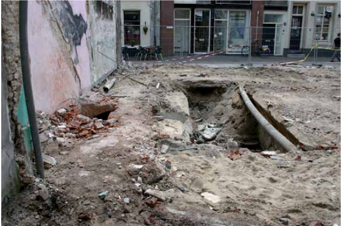
Afb. 16 Overzicht van de bouwplaats na sloop van het bovengrondse werk van het pand Stoofstraat 3. Zichtbaar zijn de restanten van de kelders onder het gesloopte pand. Rechts een deels afgehakt tongewelf van de grootste kelder, links in aanzicht een deel van het tongewelf van het smalle deel van de kelder.
