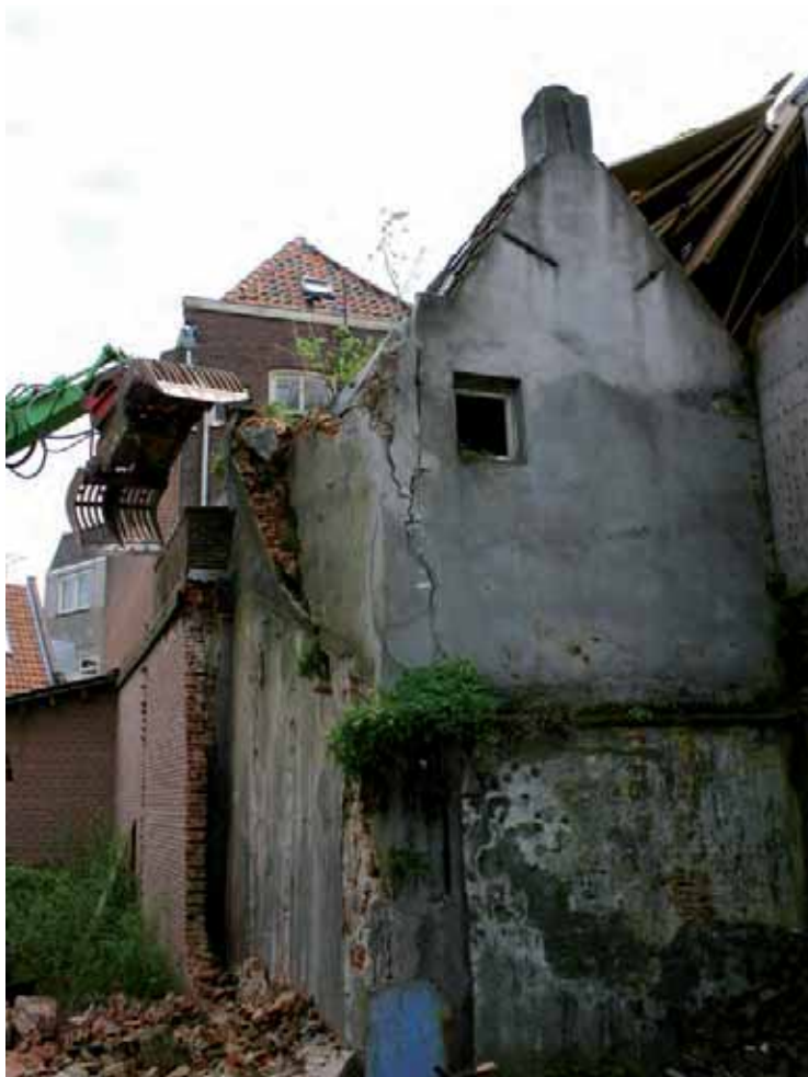
Afb. 66 Overzichtsfoto vanaf het binnenterrein tijdens de sloop met zicht op de achtergevel (tuitgevel) en de rechter zijgevel.
