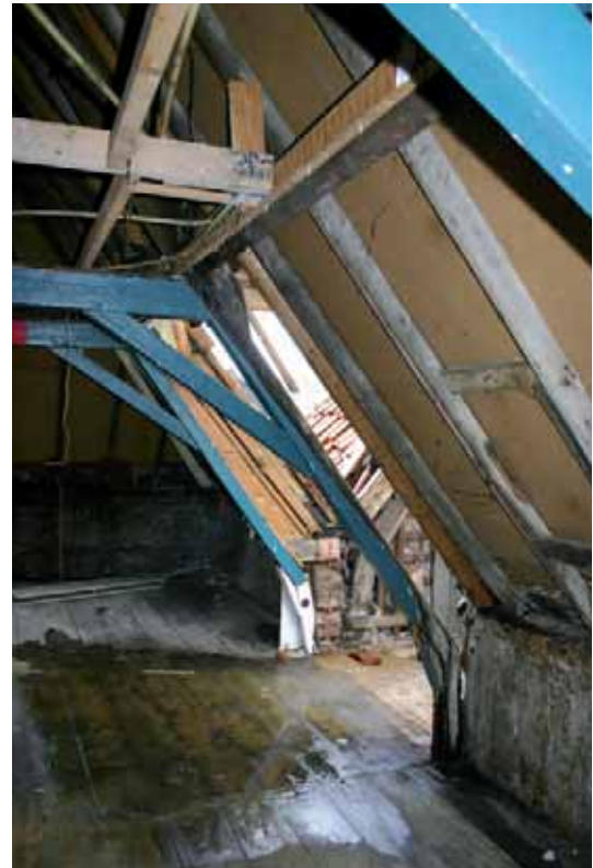
Afb. 22 Een deel van de zolder, gezien in de richting van de voorgevel, met zichtbaar de blauwgeschilderde tussenbalkspanten met korbeels en geknikte spantbenen.
