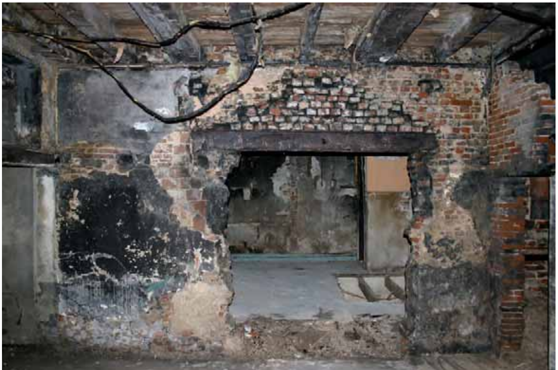
Afb. 61 De doorgang onder de latei in detail. Het metselwerk boven de latei bestaat uit louter koppen, hetgeen wijst op het hergebruik van materiaal.
