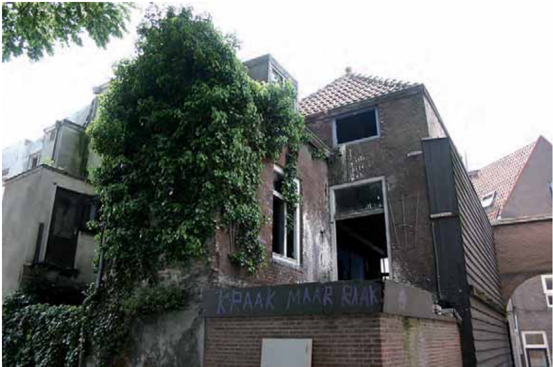
Afb. 56 Zicht op de achtergevel, de aanbouw aan de achterzijde en de achter gepotdekselde delen schuil gaande linker zijgevel.
