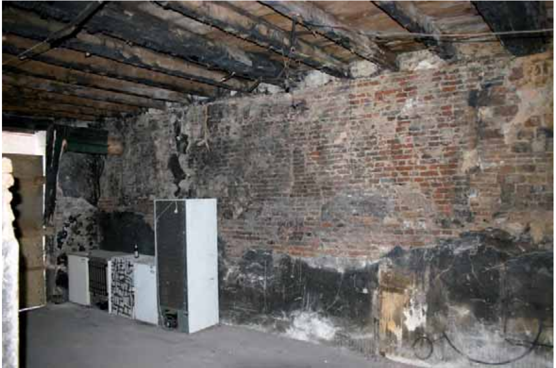
Afb. 57 De begane grond met zicht op het voorste deel van de linker zijmuur waarin in de negentiende eeuw de huidige enkelvoudige balklaag (met hergebruik van enkele moerbalken) is opgelegd. De gevel vertoont een diversiteit aan bouwsporen.
