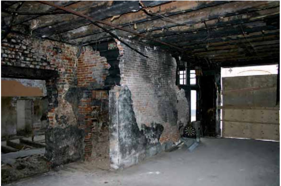
Afb. 60 Zicht op de bakstenen trapombouw en de rechter zijgevel op de begane grond. Links op de foto de twintigste-eeuwse doorgang (onder een stalen latei) met het buurpand Stoofstraat 7-9.
