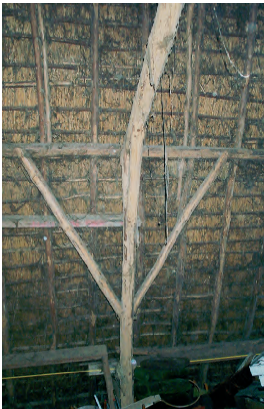
Afb. 36. Juk op het derde gebint aan de oostelijke zijde.
