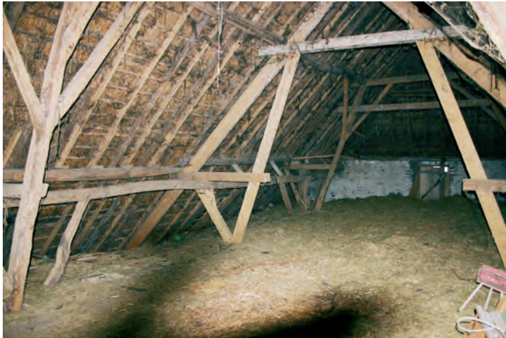
Afb. 31. Zolder stal, gezien naar het noorden.
