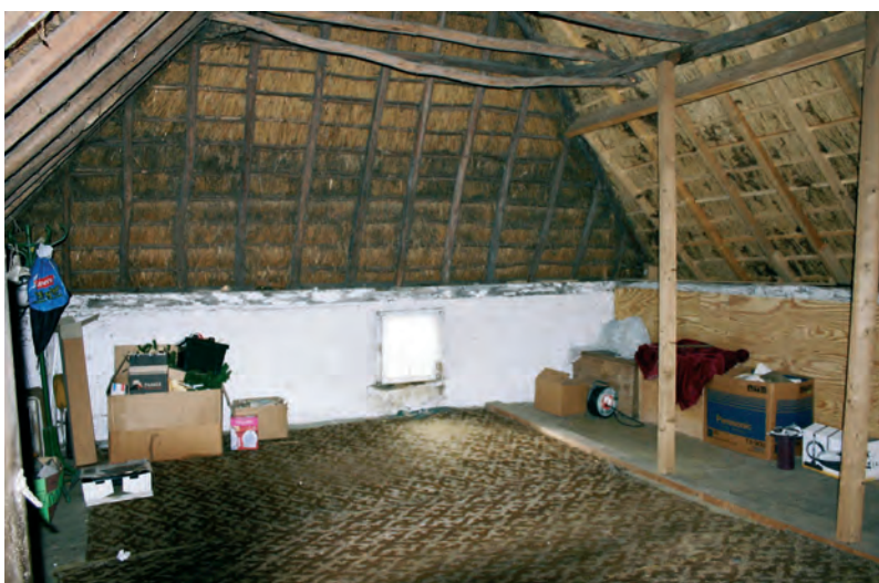
Afb. 30. Zolder woongedeelte, gezien naar het zuiden.
