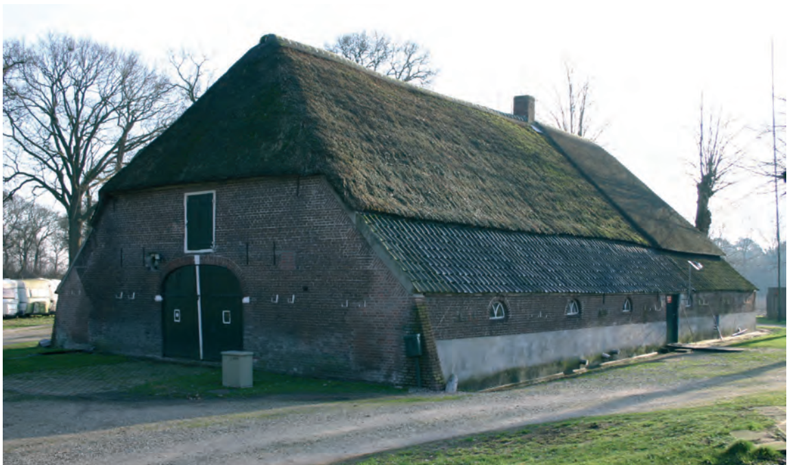
Afb. 10. Stal. Kopgevel met westgevel
