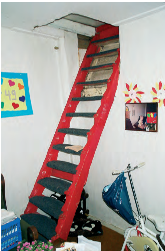
Afb. 23. Steektrap naar zolder.
