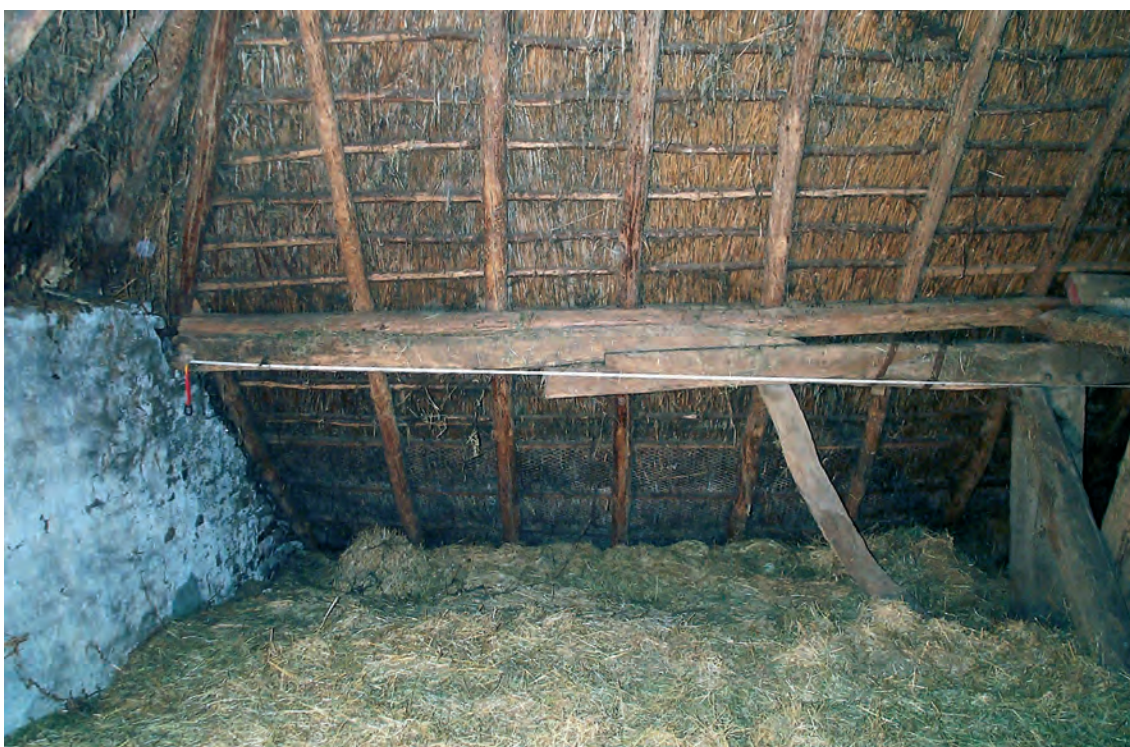
Afb. 38. Fliering aan de oostelijke zijde bij de kopgevel van de stal met de latere verlenging.
