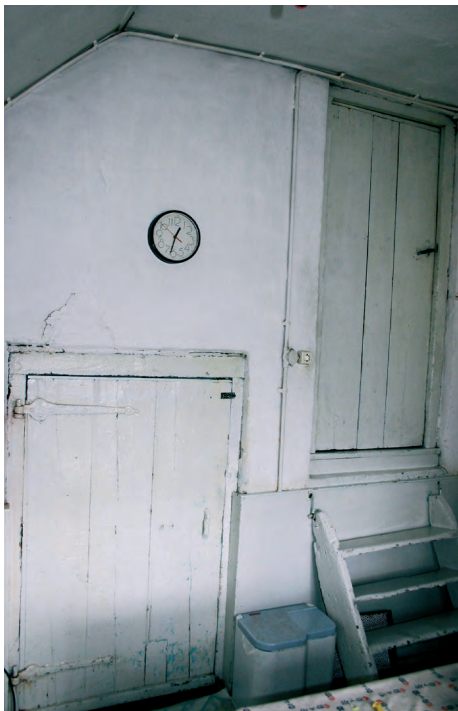
Afb. 14. Deuren naar kelder (links) en opkamer (rechts).
