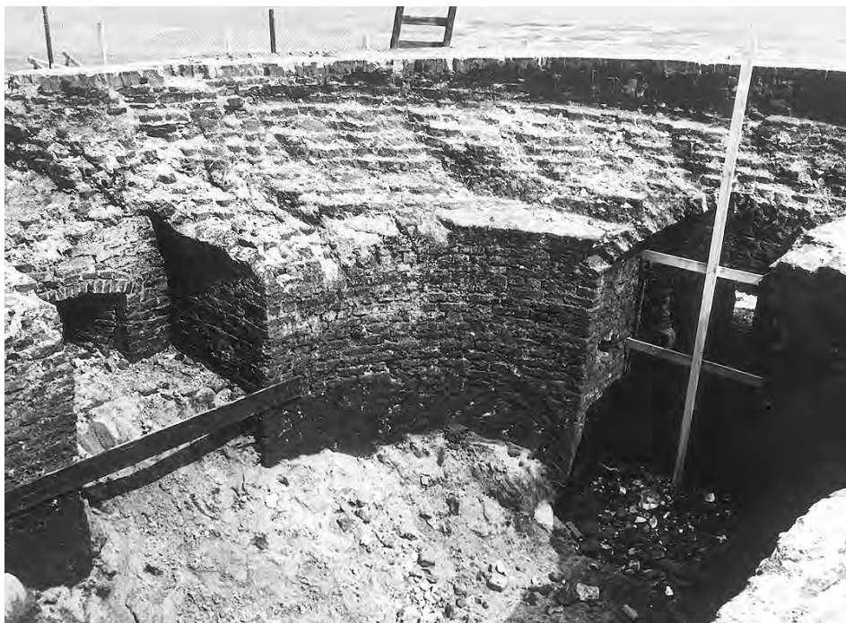
Restauratie van de 'Vuurwerkerstoren' Beckersstoren) in 1971. Tijdens het uitgraven van het restant van de toren kwamen onder meer de schietgaten in het zicht (foto-archief BAM).
