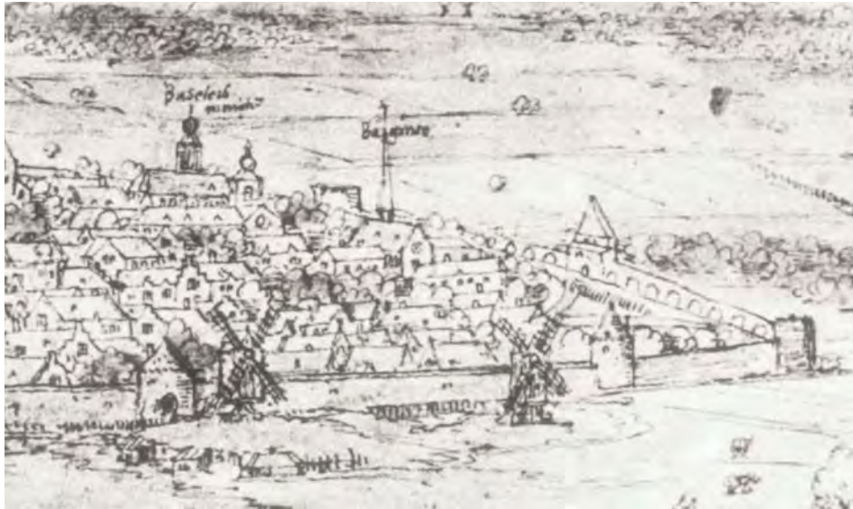
Aanzicht van de stad 's-Hertogenbosch uit 1550 vanuit het zuiden. Antoon van den Wyngaerde. Behalve de muurtorens, al dan niet met een kap, zijn rechts op de tekeningen ook de spaarbogen van de schildmuur, dragers van de weergang, afgebeeld (GAHt, Hist.Top.Atlas).
