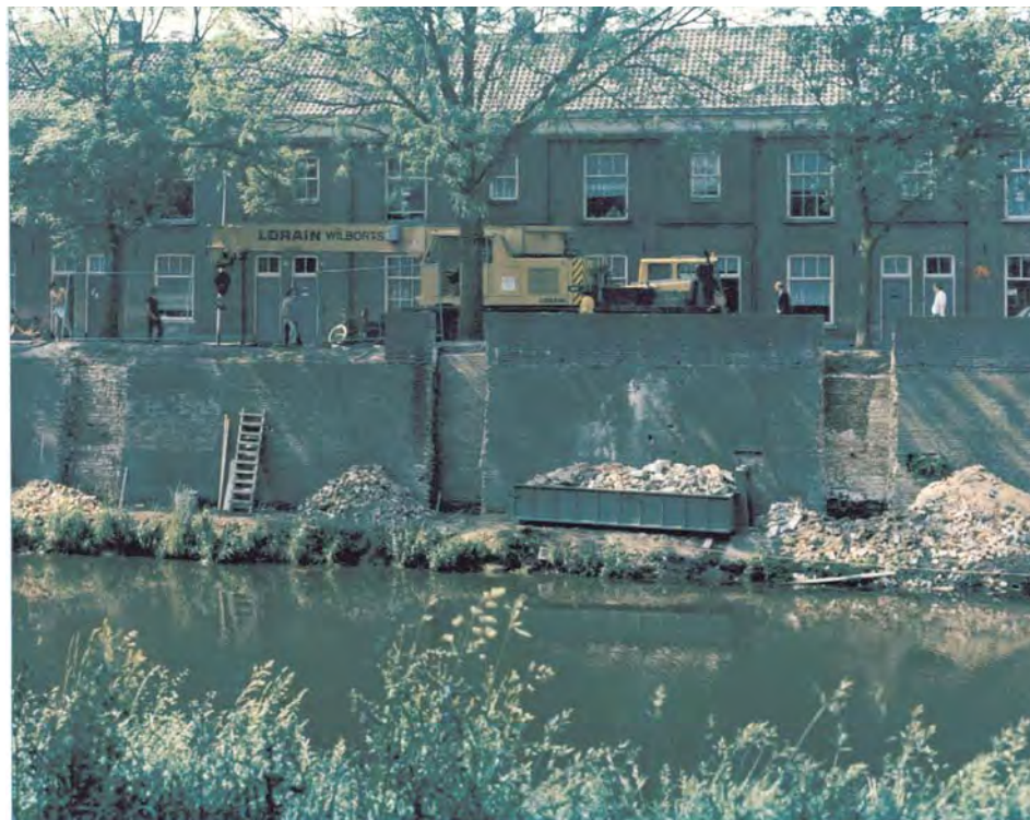
Om de stadsmuur te beschermen tegen de verwoestende kracht van de boomwortels werden sleuven in de muur gekapt waar platen van gewapend betonnen in werden verankerd. Vervolgens werden deze platen weggewerkt achter een bakstenen schil (foto-archief BAM).
