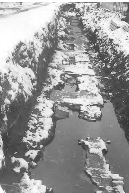
Tijdens een opgraving in de Hofstad kwam het tracé van de oude stadsmuur in het zicht. Duidelijk is hier de muur met op regelmatige afstanden de poeren te zien (foto-archief BAM).
