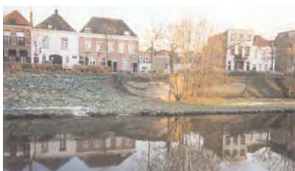
Stadsmuur, rondeel en aarden talud aan de St.-Janssingel. Ook hier is alleen het onderste deel van de verdedigingswerken bewaard gebleven. De buitenste schil van de stadsmuur en het rondeel is in verval geraakt (foto BAAC bv).
