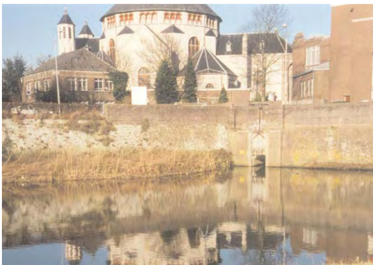
De Kruisbroedershekel. Deze hekel speelt nog steeds een rol in de waterverversing van de Binnen-dieze (foto BAAC bv)
