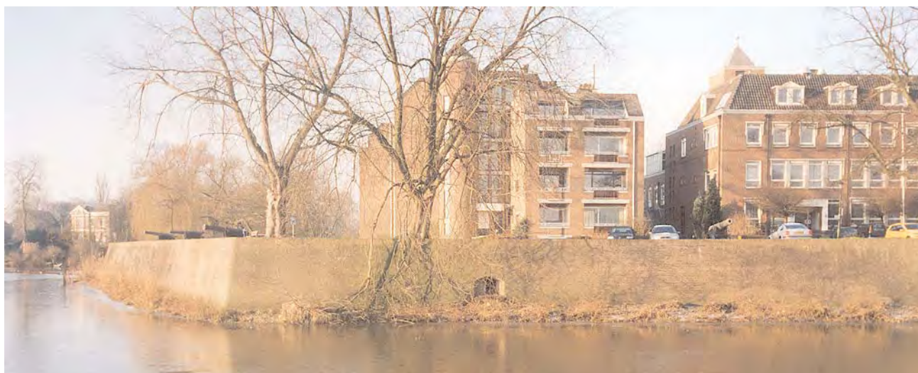
Gezicht op de linker flank van bastion Vught met het schietgat behorende bij de kazemat (foto BAAC bv).
