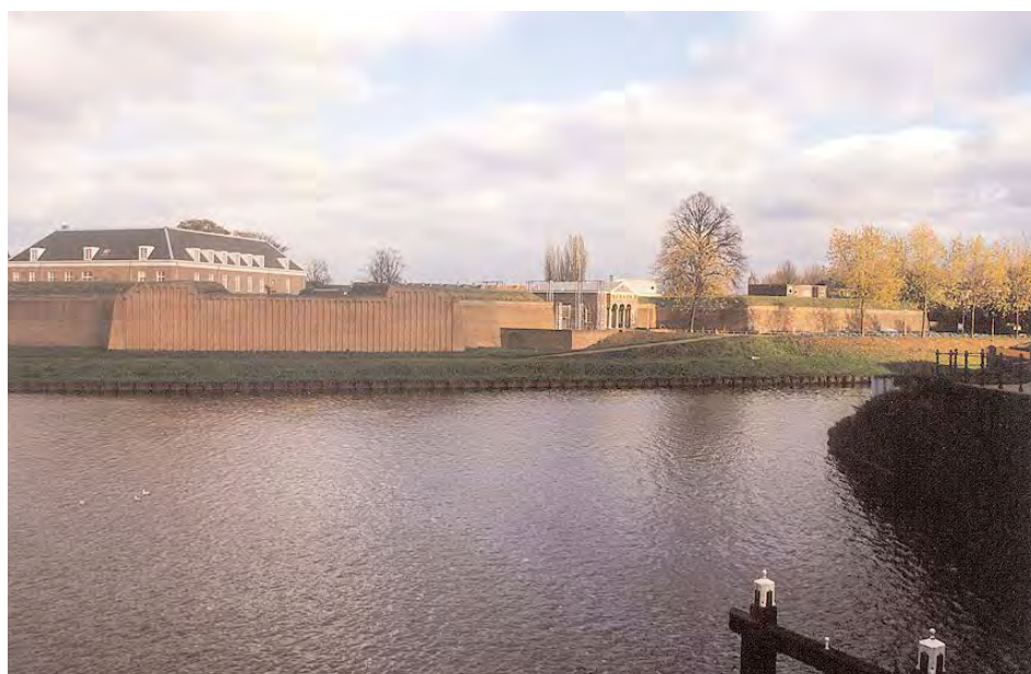
Foto van de Citadel anno 1999 waarop het restant van het gesloopte bastion I is te zien en de toegangspoort die uit 1899 dateert (foto BAAC bv).
