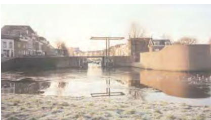
Restant van de eind twintigste eeuw gerestaureerde en gereconstrueerde rechter toren van de Boempoort. (foto BAAC bv).
