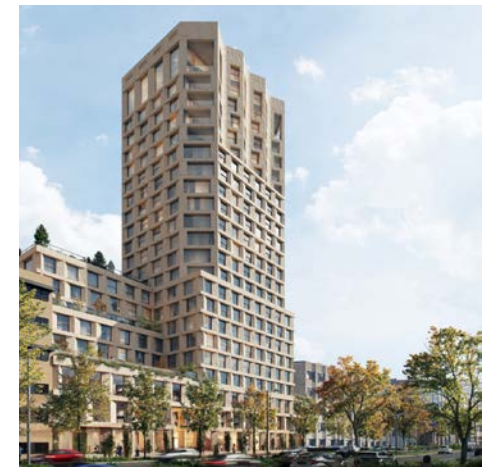
De toren is alzijdig vormgegeven.
