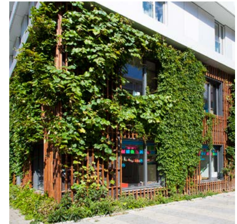
Groene gevels worden integraal mee ontworpen met de architectuur van het gebouw.
