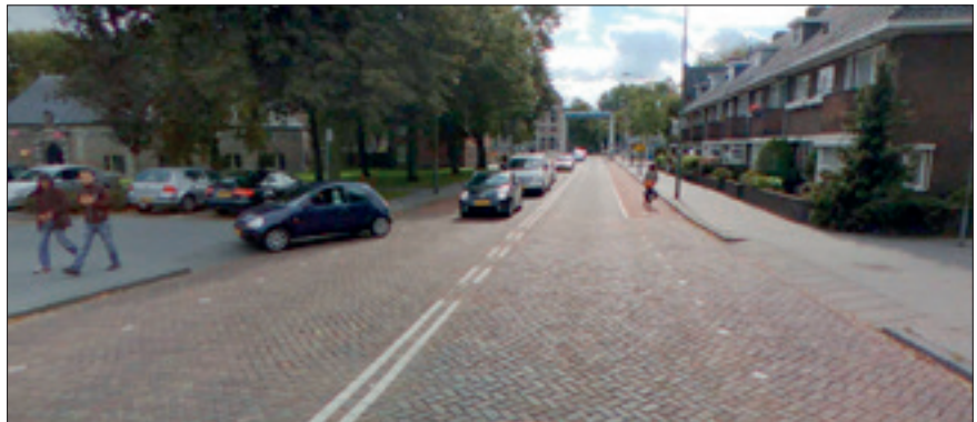
'Nieuwe binnenstadsring': rijbaan gebakken klinkers, fietssuggestiestroken m.b.v. natuursteen blokjes
