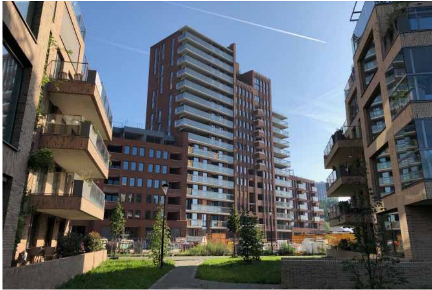
Willemspoort Noord bestaande situatie
