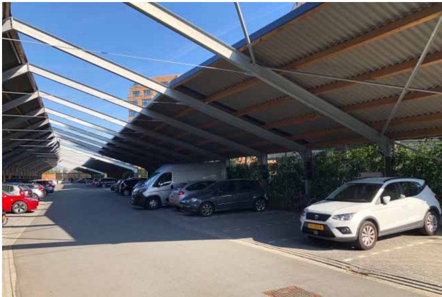
Willemspoort Carport combinatie van PV cellen en geluidswering
