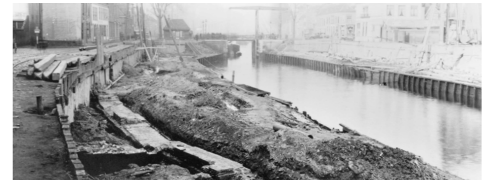
Restanten van kademuren van een oude Diezetak in Sluis 0 tijdens de verbreding in 1932.
