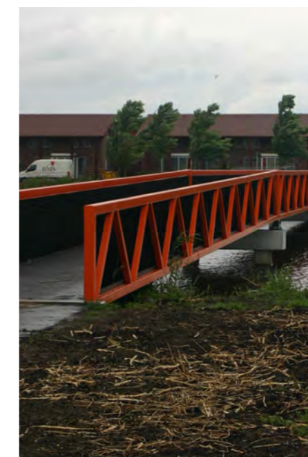
Tijdelijke verbinding kan bijvoorbeeld bestaan uit een tweedehands Baileybrug.
