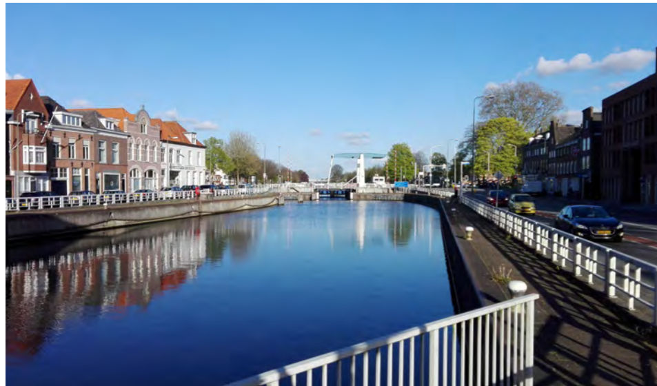
Huidig beeld van de sluiscom met rechts de kade (met de bolders en het hekwerk), die ingepast kan worden.
