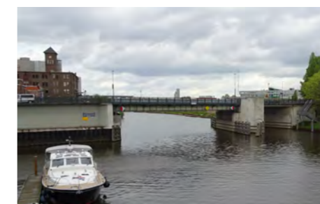
Onderdoorgangen zijn in breedte en hoogte is gedimensioneerd op de beroepsvaart.
