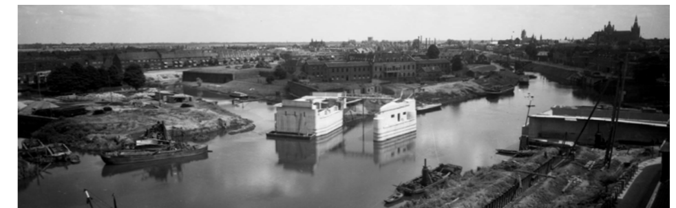
1939: Aanleg van de Diezebrug: de pijlers tussen Aa en Zuid-Willemsvaart, met de Citadel op de achtergrond.
