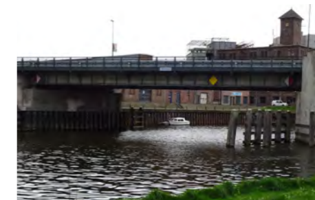
Onderdoorgang is in breedte en hoogte is gedimensioneerd op de beroepsvaart.
