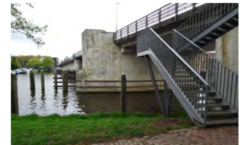
Verbinding voor voetgangers tussen het brugdek van de Diezebrug en het maaiveld voor de Citadel.
